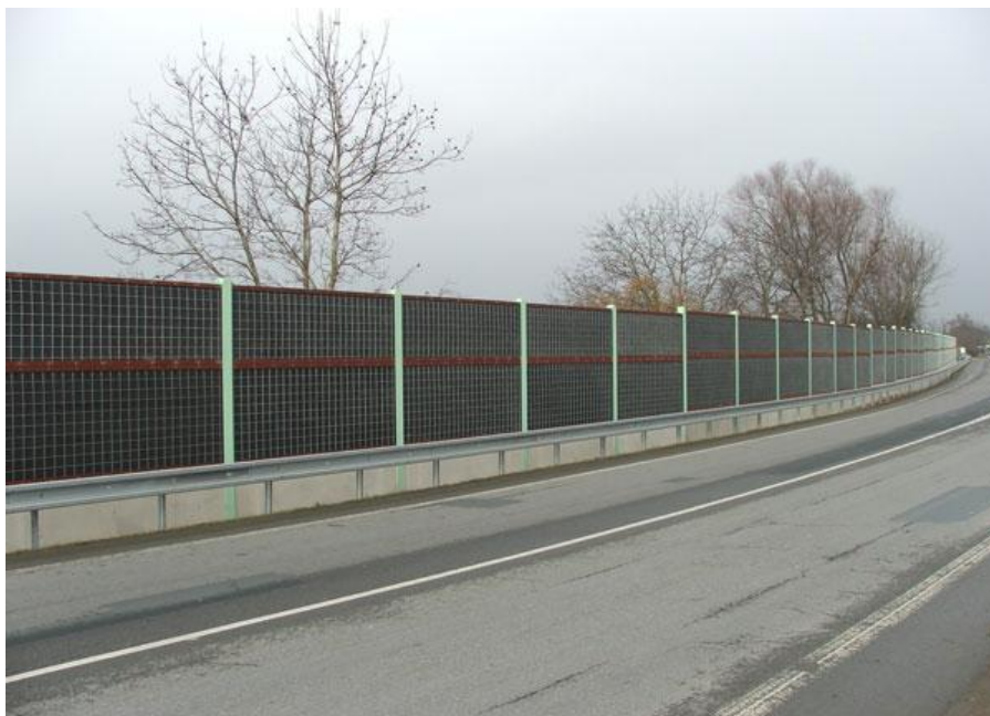
Obrázek 11 - Protihluková stěna ze sklovláknového betonu [13]
