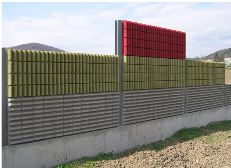
Obrázek 12 - Protihluková stěna z dřevocementových tvarovek [13]
