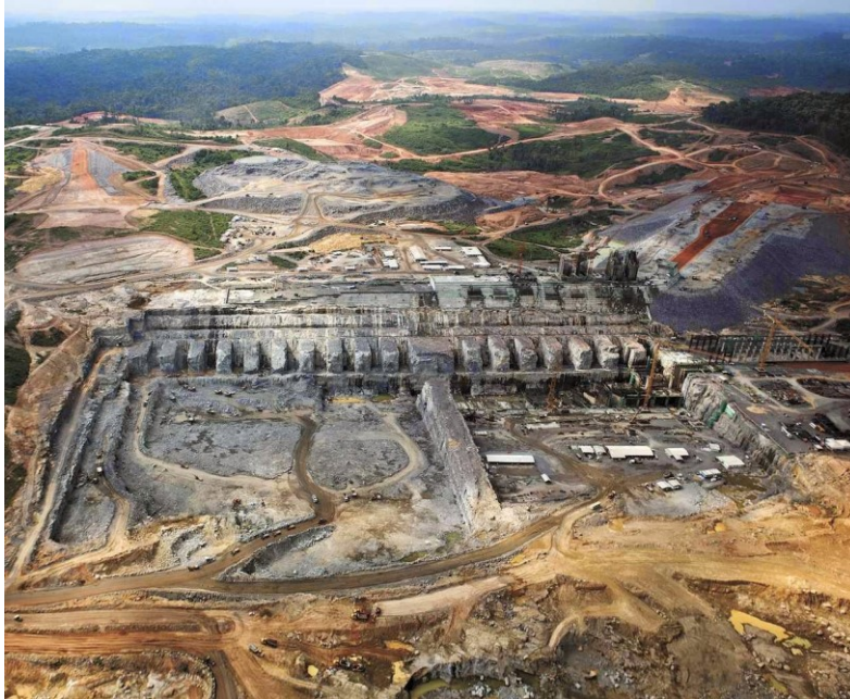
Obrázek č. 8: Konstrukce přehrady Belo Monte
