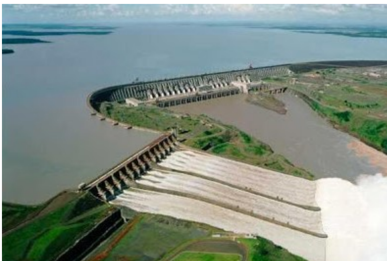
Obr. č. 9: Finalizace výstavby Belo Monte
