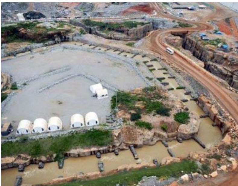
Obr. č.13: Výstavba elektrárny Santo Antonio
