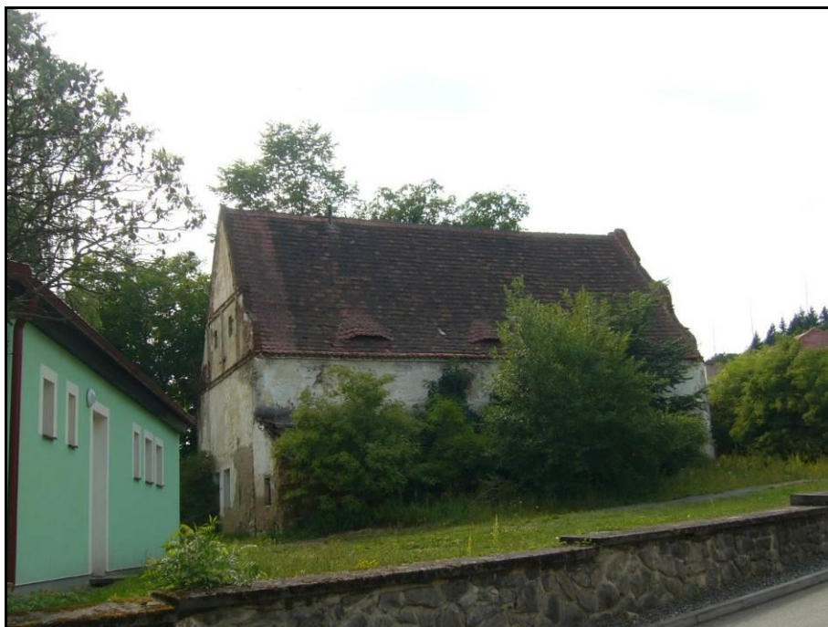
Obrázek č. 8: Sýpka č. p. 30 v Miloňovicích
