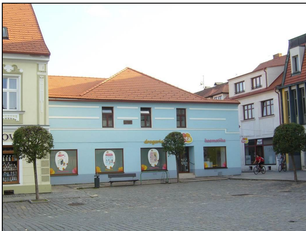
Obrázek č. 7: Měšťanský dům č. p. 8 na nám. Svobody ve Vodňanech
