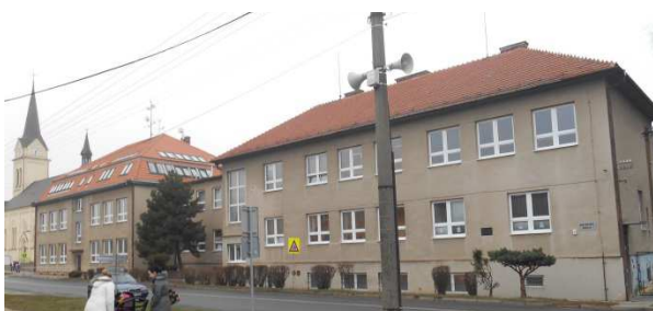
Budova základní školy
