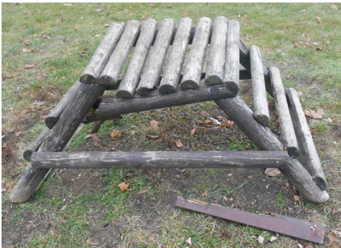
Dřevěná průlezka v pokročilém stádiu rozpadu
