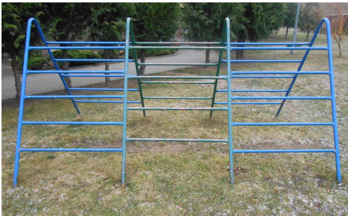
Opotřebení povrchového nátěru na průlezkách
