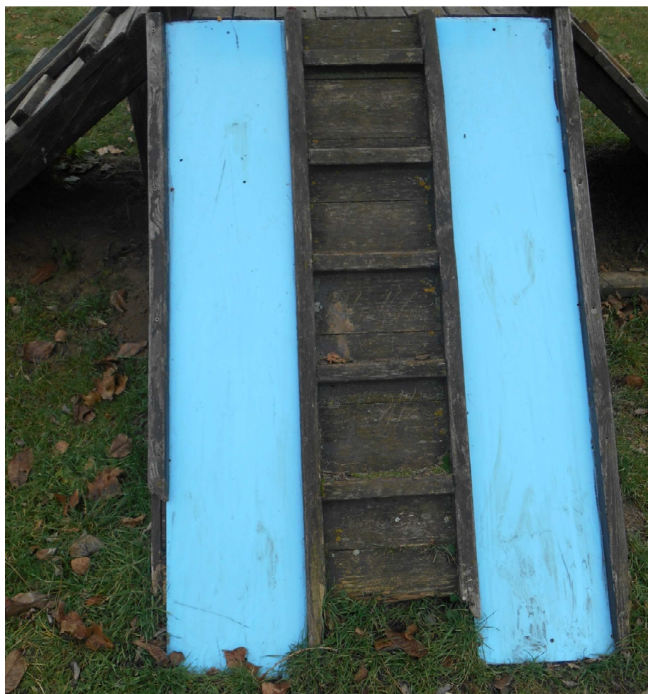
Detail trouchnivějící a poničené průlezky
