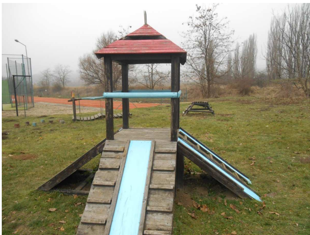
Trouchnivějící dřevěná průlezka
