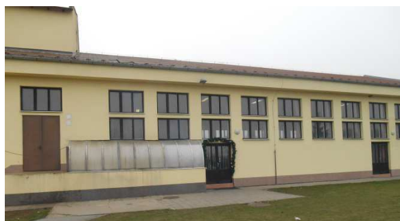
Víceúčelová sportovní hala za budovou OÚ
