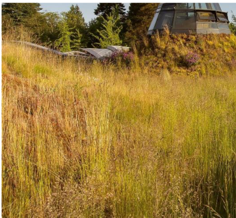
Obrázek 20: extenzivní travnatá střecha na VanDusenově botanické zahradě
