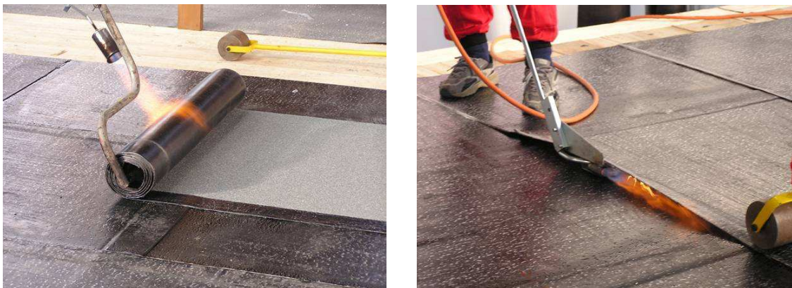
Obr. 5.4 Způsob natavování parozábrany (zdroj: [5])
