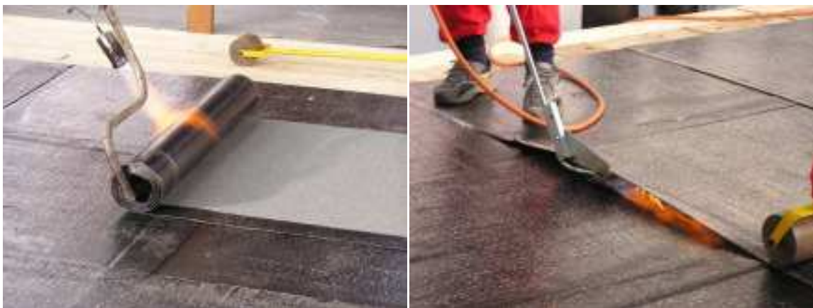
Obr. 4.3 Způsob natavování parozábrany (zdroj: [5])
