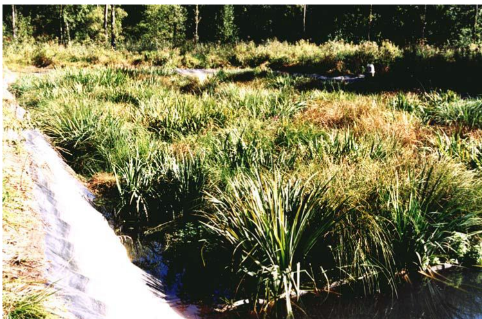
Obrázek 18: Mokřad řešený pomocí rohože z kokosových vláken, jež je nesena PE sítí a PS pěnou (Headley a Tanner, 2006).
