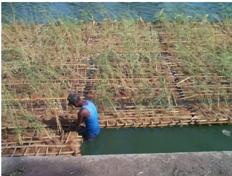
Obrázek 19: Výroba plovoucích vorů pomocí bambusu v Indii (Headley a Tanner, 2006).
