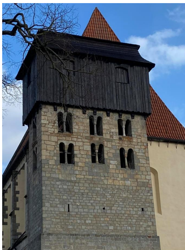
Obr. 30 Záběr na střechu věže
