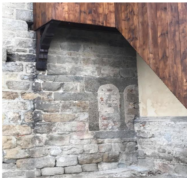
Obr. 26 Zazděná okna pod vchodem do věže
