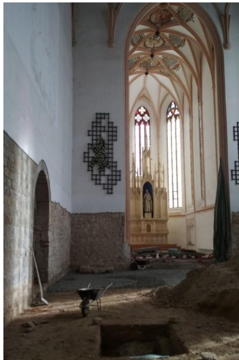
Obr. 36 Pohled na prováděné vykopávky.
