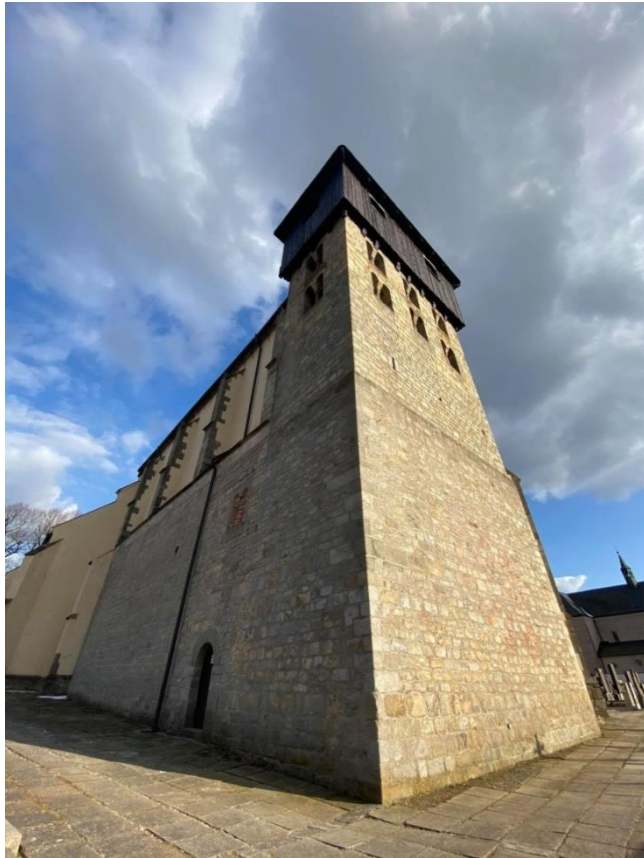
Obr. 23 Pohled na románskou věž
