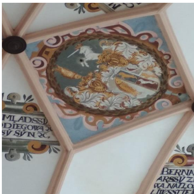
Obr. 11 Klenba milevského typu znak č. 2
