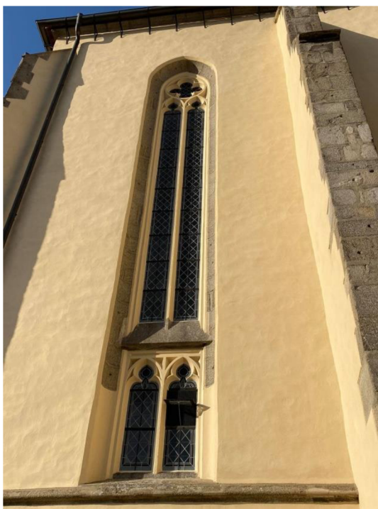
Obr. 33 Pohled na okno v chrámu u románské věže.
