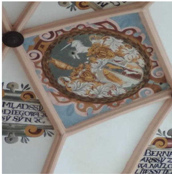
Obr. 11 Klenba milevského typu znak č. 2
