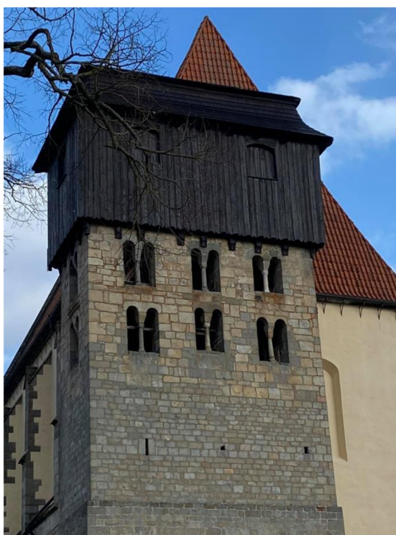
Obr. 30 Záběr na střechu věže
