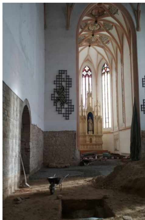
Obr. 36 Pohled na prováděné vykopávky.
