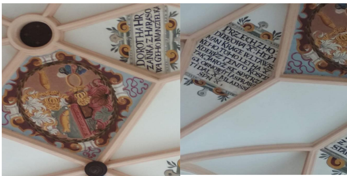
Obr. 14 Klenba milevského typu, pole se jmény rodů 3. a 4.
