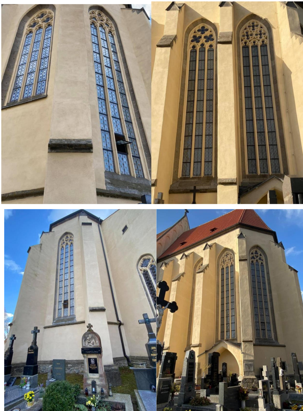
Obr. 46 Okna v presbytáři.
