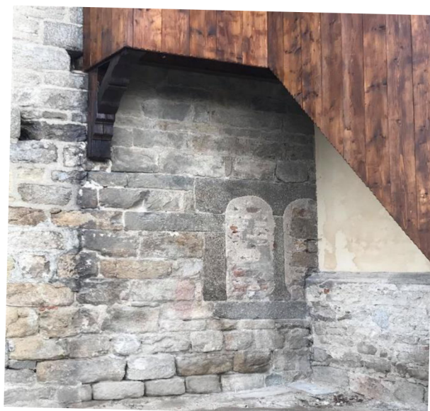
Obr. 26 Zazděná okna pod vchodem do věže
