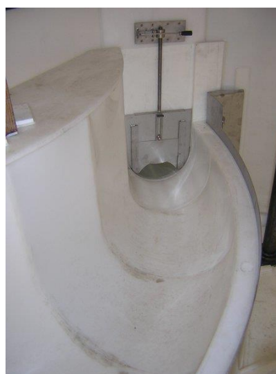
Obr. 3.2.6 Štěrbínová plastová odlehčovací komora od firmy ASIO [8]
