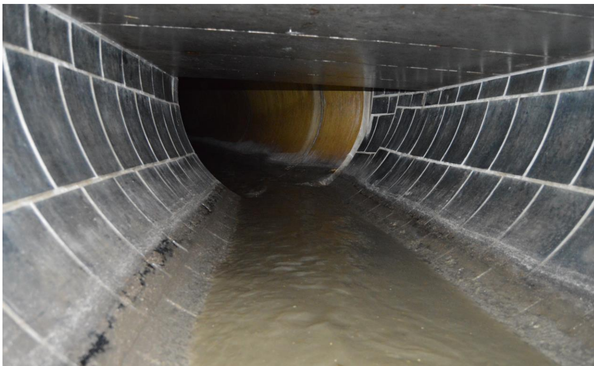
Obr. 6.2.4 Splaškový průtok pod dělicí stěnou
