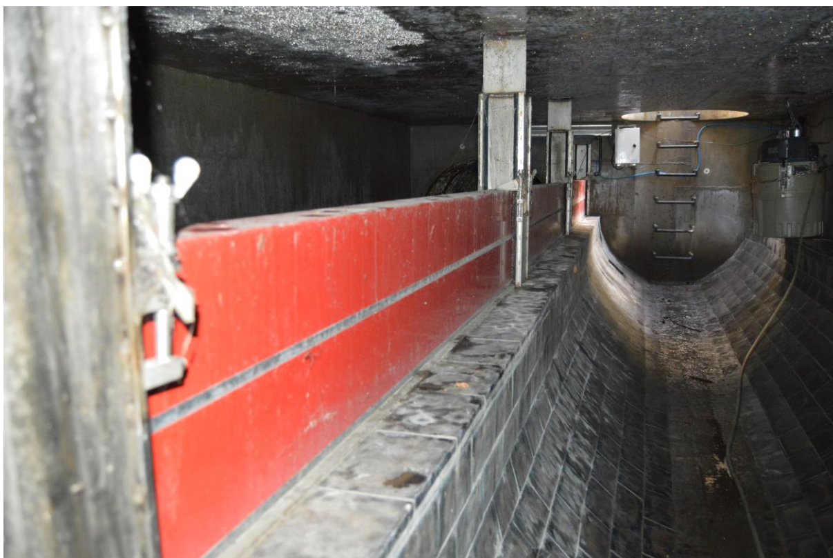
Obr. 6.3.4 Přepadová stěna z hradidlových uzávěru
