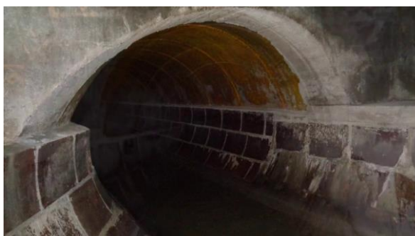
Obr. 3.2.1 Kameninový obklad na betonové stoce [5]
