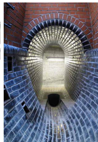
Obr. 3.1.19 Nátok do odlehčovací komory [9]
