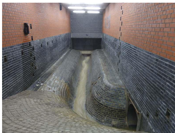
Obr. 3.2.3 Čedičový obklad odlehčovací komory [7]
