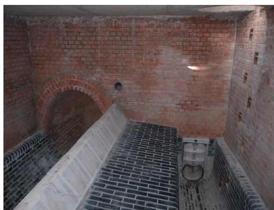
Obr. 3.1.10 OK s přepadem jednostranným přímým [24]
