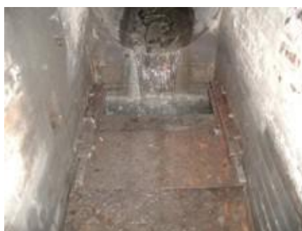
Obr. 3.1.14 OK s přepadajícím paprskem splaškové vody[24]
