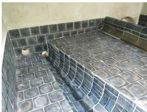
Obr. 3.2.2 Betonová odlehčovací komora s čedičovou výstelkou [8]
