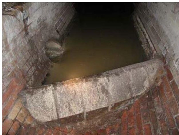
Obr. 3.1.5 OK s přepadem přímým šikmým [24]
