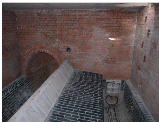
Obr. 3.1.10 OK s přepadem jednostranným přímým [24]
