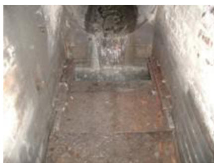
Obr. 3.1.14 OK s přepadajícím paprskem splaškové vody[24]
