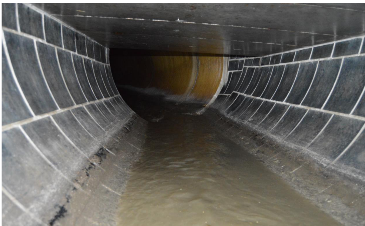
Obr. 6.2.4 Splaškový průtok pod dělicí stěnou
