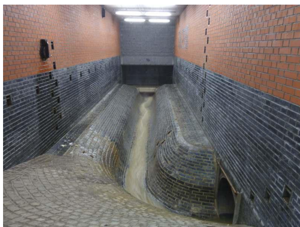
Obr. 3.2.3 Čedičový obklad odlehčovací komory [7]
