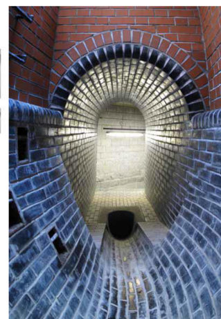
Obr. 3.1.19 Nátok do odlehčovací komory [9]
