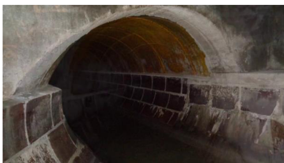
Obr. 3.2.1 Kameninový obklad na betonové stoce [5]
