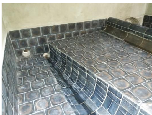
Obr. 3.2.2 Betonová odlehčovací komora s čedičovou výstelkou [8]
