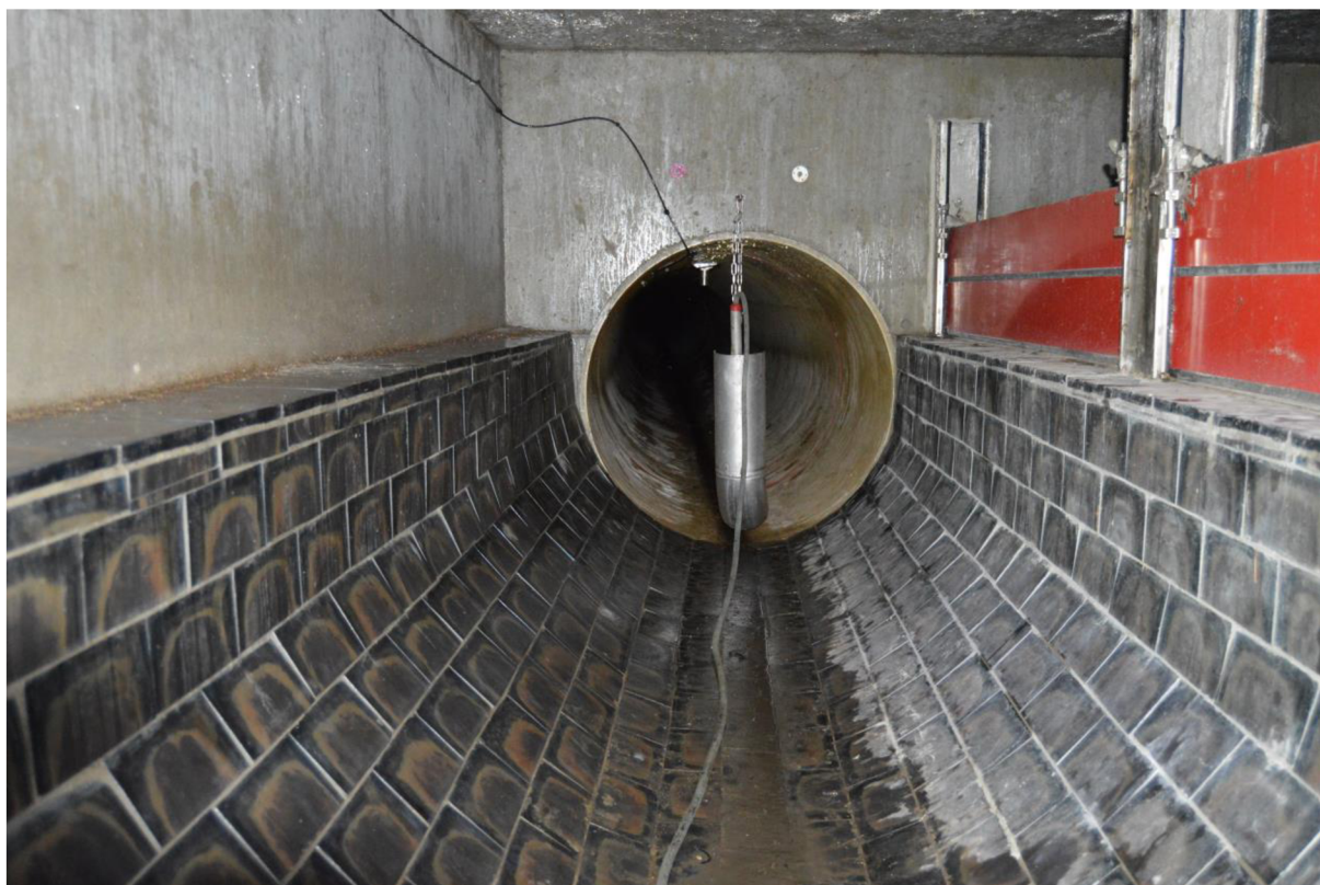
Obr. 6.3.5 Odlehčovací stoka
