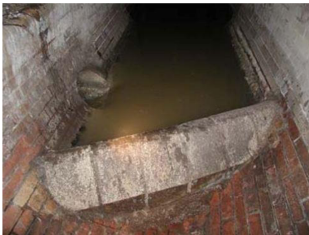
Obr. 3.1.5 OK s přepadem přímým šikmým [24]
