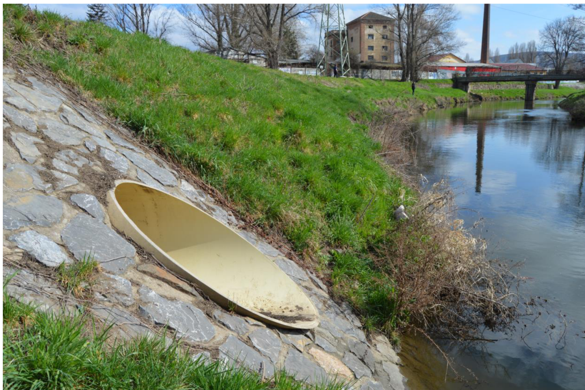
Obr. 6.3.6 Vyústění odlehčovací stoky do Svitavy
