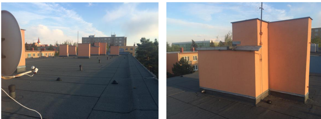
Obrázek 6 Současný stav střechy a staré expanzní nádoby
