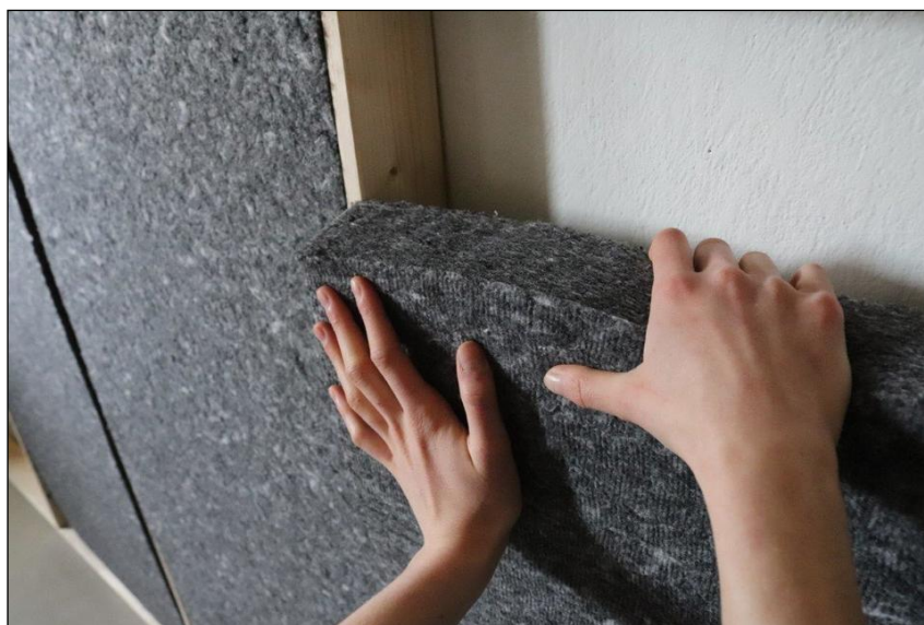
Obrázek 10 Recyklovaný textil jako izolační materiál [47]
