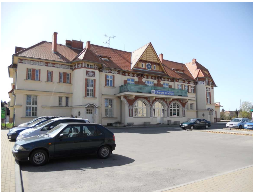
Obr. 1 Hlavní budova železniční stanice Uherské Hradiště
