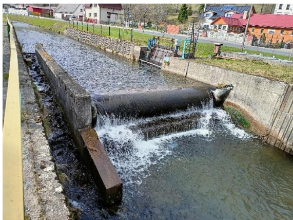
Obrázek 11: Jez na říčce Staříč v obci Lipová-Lázně
