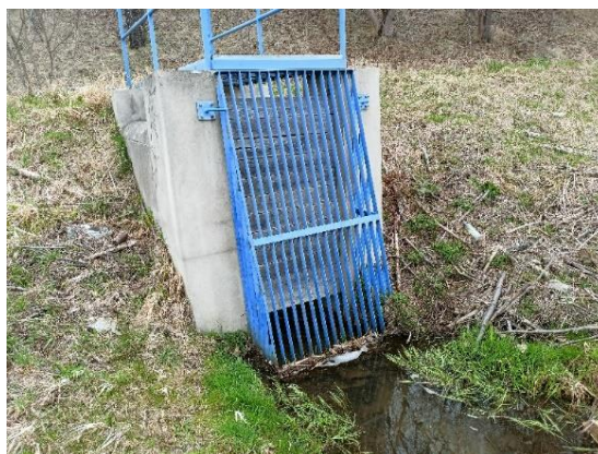
Obrázek 10: Zatrubněný úsek pravostranného přítoku Staříče (Mlýnský potok) (foto: autor, 2024)
