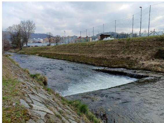
Obrázek 7: V obytné zóně města Jeseník je koryto Staříče výrazně zahloubené a opevněné ochrannou hrází z kamene (foto: autor, 2024)
