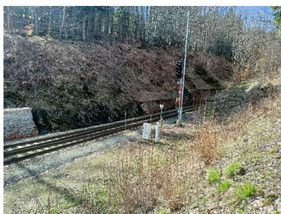
Obr. 19: Průkop podél železniční trati 292 nedaleko železniční stanice Horní Lipová (foto: autor, 2024)
