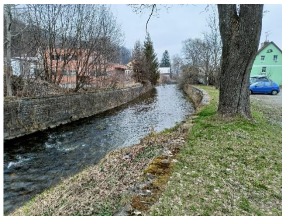
Obrázek 9: Koryto Staříče je nedaleko soutoku s Bělou výrazně změněno kolmou ochrannou hrází z kamene. (foto: autor, 2024)
