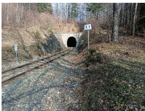
Obrázek 20: Železniční tunel na trati 295 (foto: autor, 2024)
