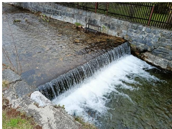
Obrázek 12: Stupeň na říčce Staříč v obci Lipová-lázně
