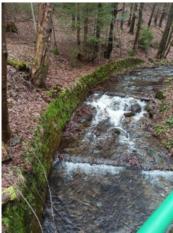
Obrázek 13: Dvojice prahů na horním toku říčky Staříč (foto: autor, 2023)
