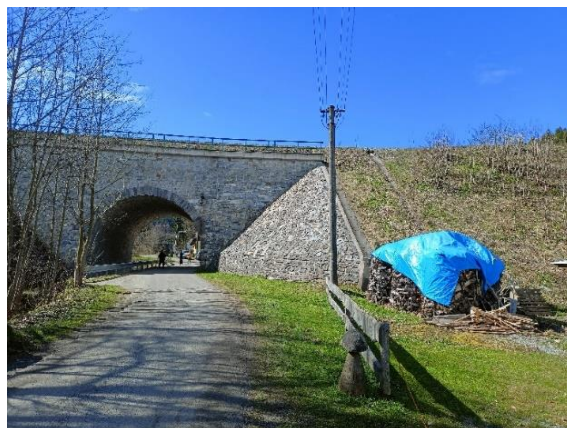
Obrázek 17: Železniční násep trati 292 nedaleko železniční stanice Horní Lipová (foto: autor, 2024)
