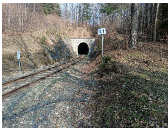
Obrázek 20: Železniční tunel na trati 295 (foto: autor, 2024)
