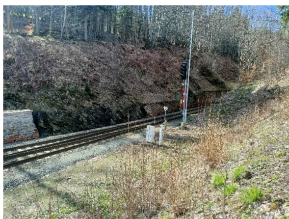
Obr. 19: Průkop podél železniční trati 292 nedaleko železniční stanice Horní Lipová (foto: autor, 2024)
