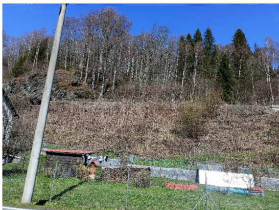
Obrázek 18: Odkop podél železniční trati 292 nedaleko železniční stanice Horní Lipová (foto: autor, 2024)
