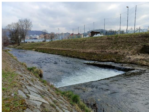
Obrázek 7: V obytné zóně města Jeseník je koryto Staříče výrazně zahloubené a opevněné ochrannou hrází z kamene (foto: autor, 2024)
