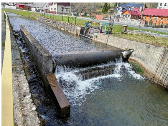
Obrázek 11: Jez na říčce Staříč v obci Lipová-Lázně
