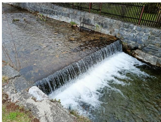
Obrázek 12: Stupeň na říčce Staříč v obci Lipová-lázně
