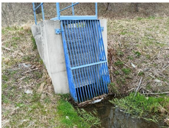
Obrázek 10: Zatrubněný úsek pravostranného přítoku Staříče (Mlýnský potok) (foto: autor, 2024)
