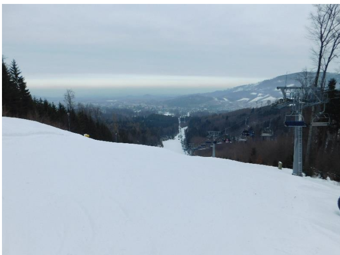
Obr. 36 Příčný sklon červené sjezdovky
