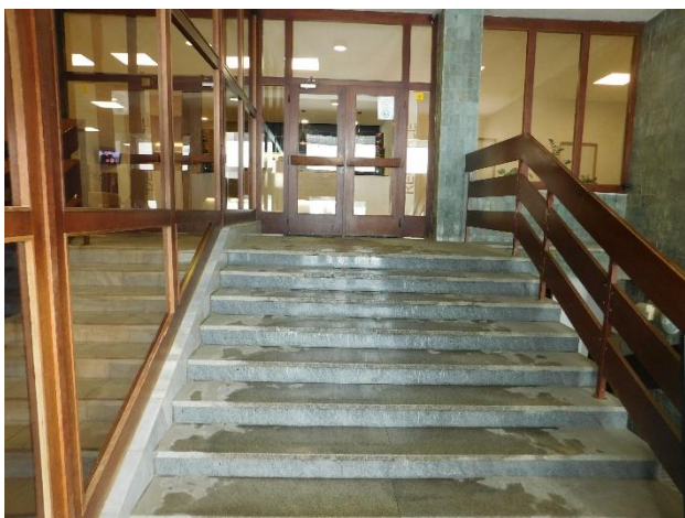
Obr. 106 Přístup do hotelu 2
