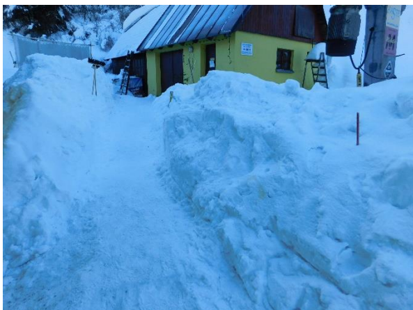
Obr. 68 Přístup k vleku 2 (KASTE)
