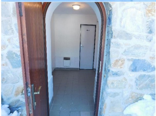
Obr. 60 Vstup na WC 2 (KASTE)
