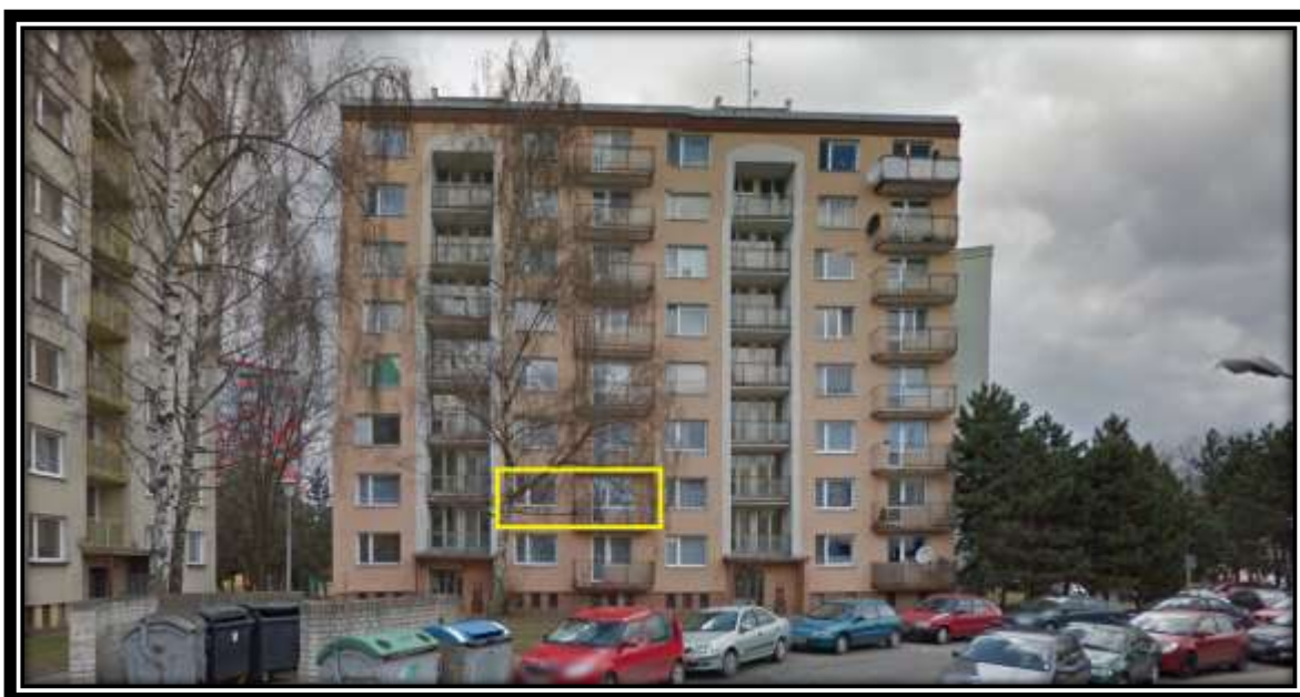
Obrázek č. 6.1 b): byt č. 1, průčelí bytového domu.
