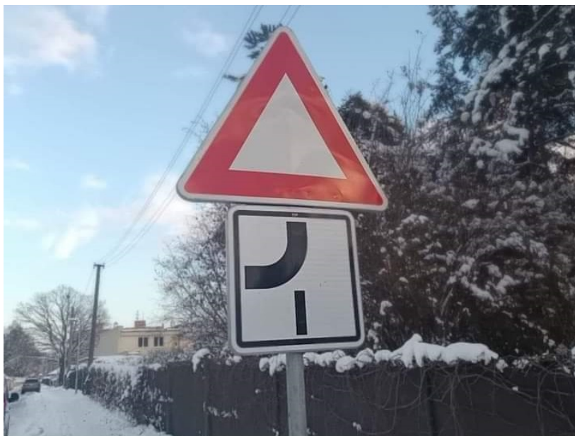
Obrázek 17: chybná instalace DZ č. P 4 49
