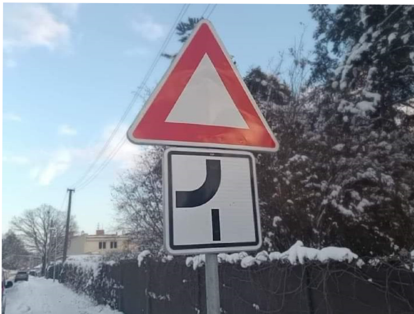
Obrázek 17: chybná instalace DZ č. P 4 49
