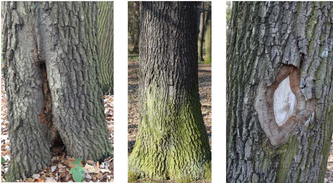
Příloha 15 – poškození – dub – praskliny
