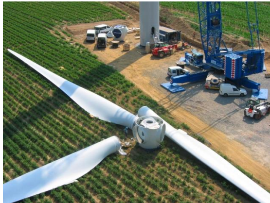
Obr. 24 Sestavení rotoru na zemi [16]
