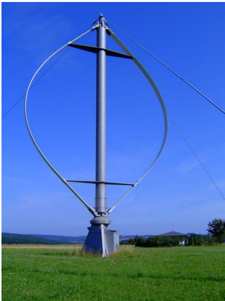
Obr. 34 Rotor Darrieus typu \Phi [21]
