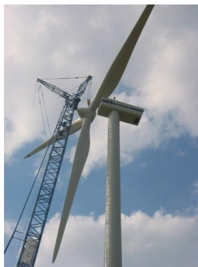
Obr. 25 Usazení rotoru k ose převodovky [16]
