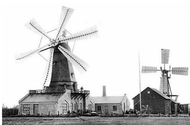
Obr. 4 Větrné elektrárny Poula la Coura [1]
