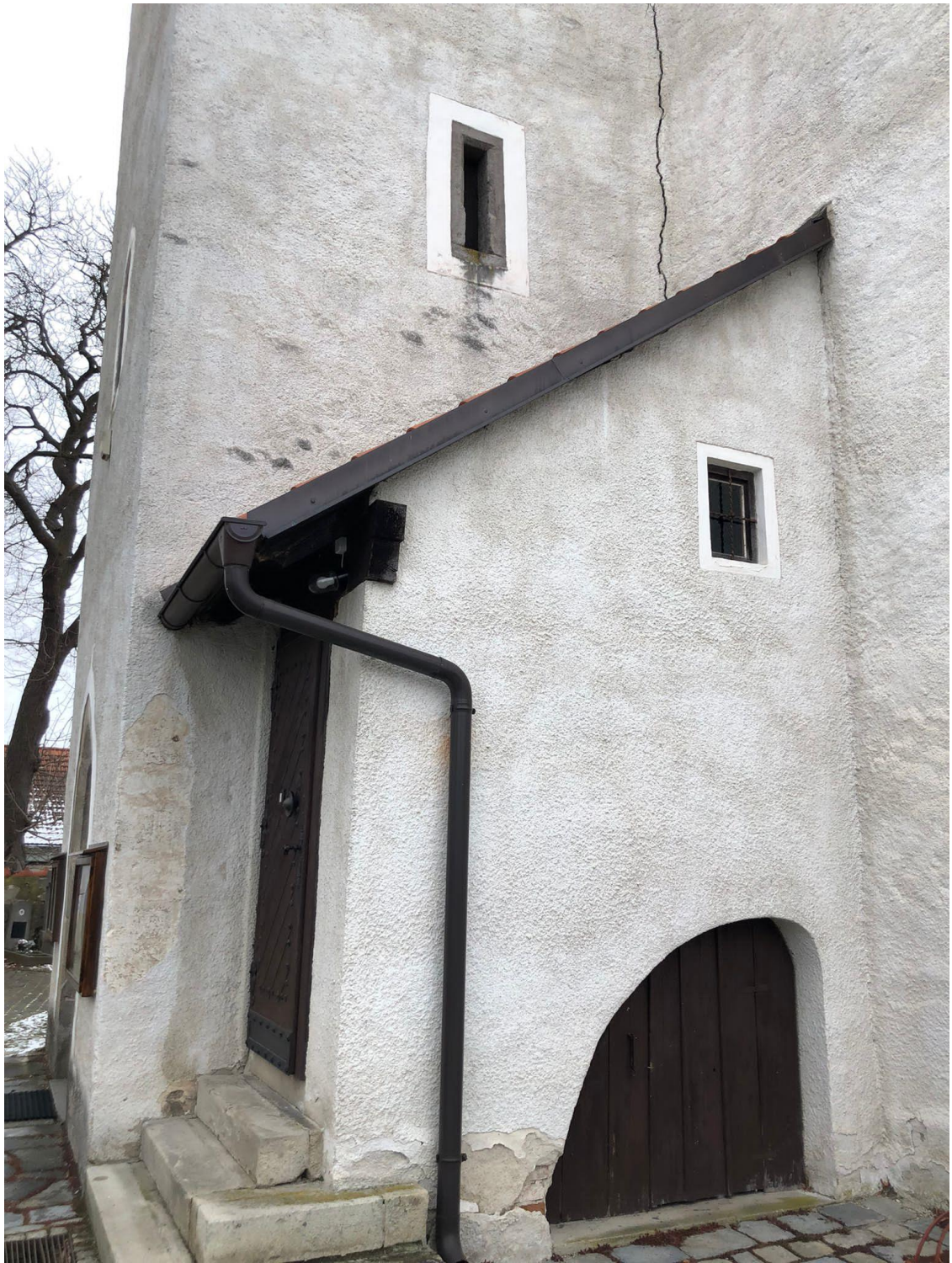
Obrázek č. 3: jižní strana věže s přistavěným vchodem
