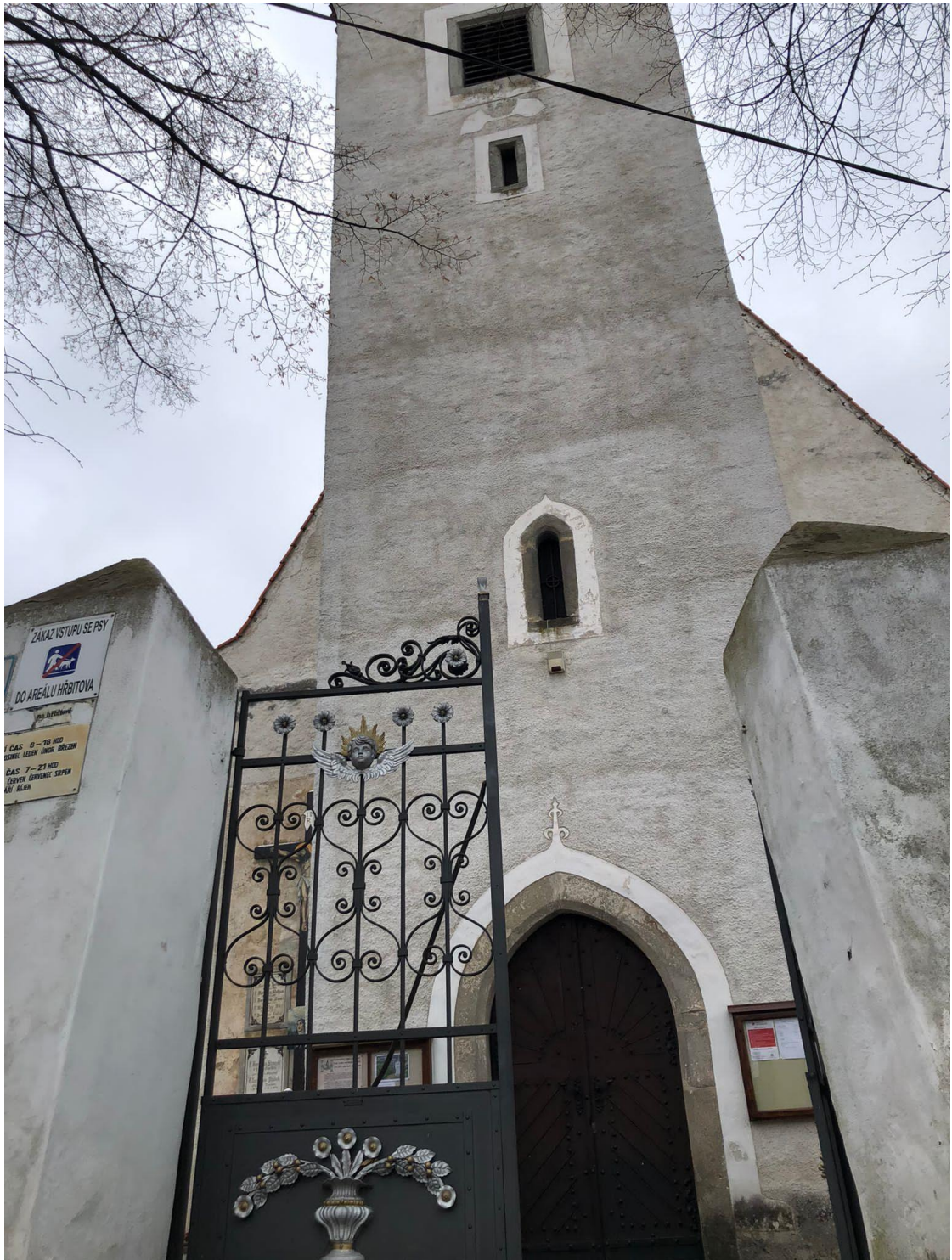
Obrázek č. 2: západní strana věže v průčelí
