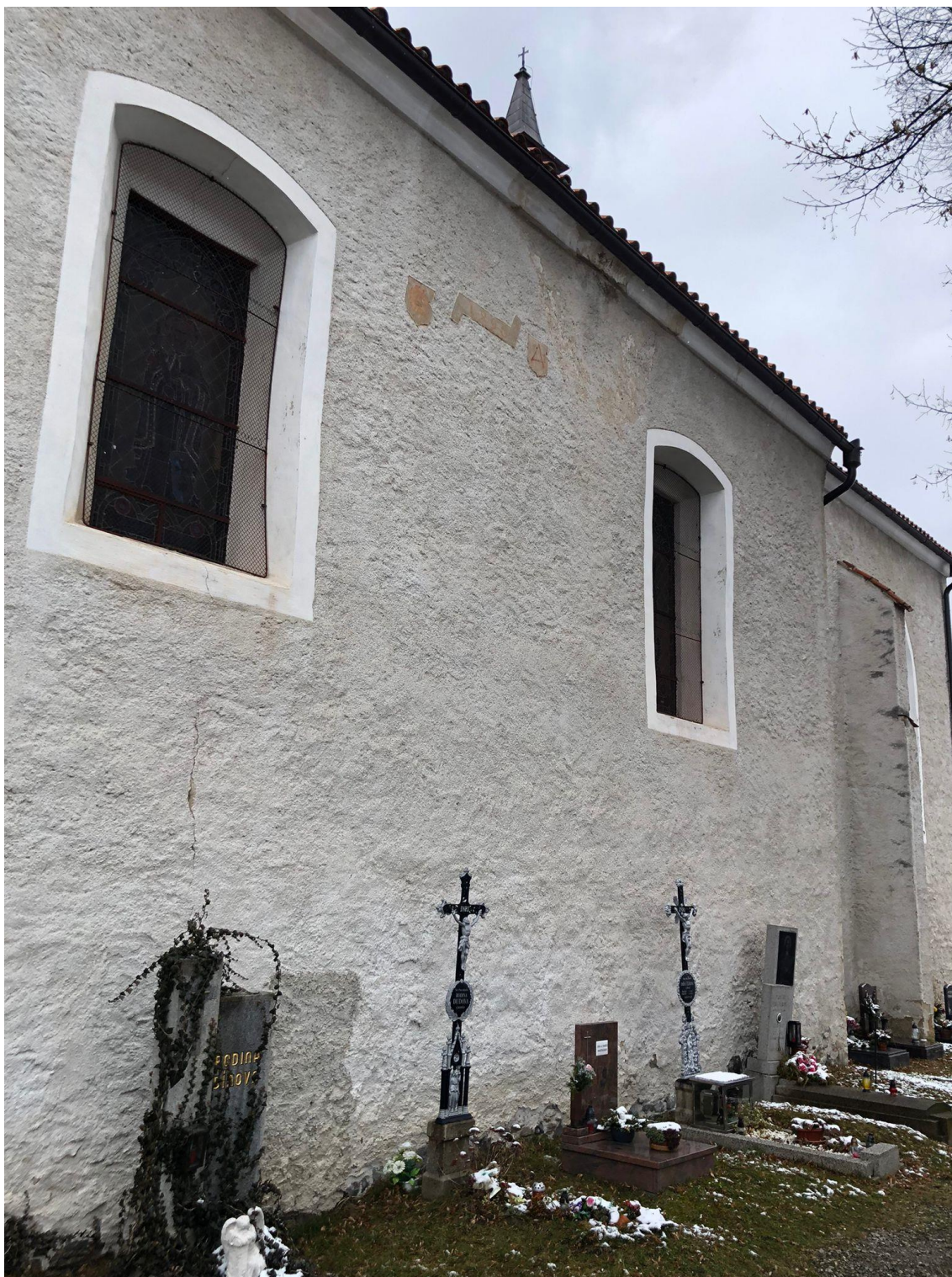
Obrázek č. 6: jižní fasáda lodi
