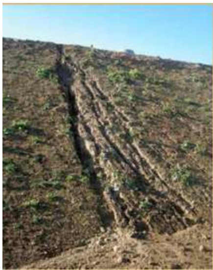
Obrázek č. 4 Ukázka rýžkové eroze (URL 4)
