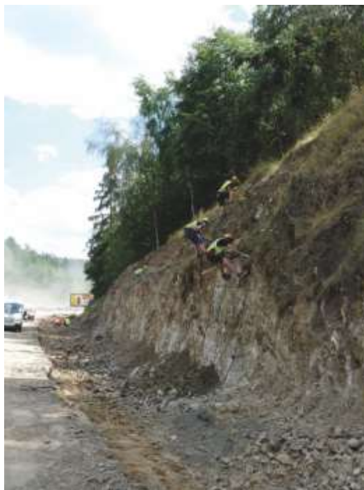
Obrázek č. 18 Odtěžení skalního masivu (URL 18)
