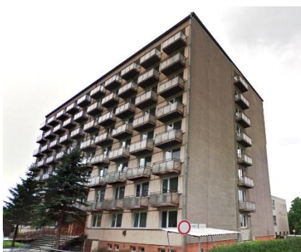
Obrázek č. 10 Centrum pro seniory Holešov (zdroj: www.cpsholesov.cz )
