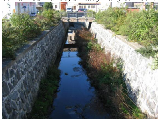
Obr. 24: Přeložka řeky Svitavy v ul. Školní a na Komenského nám., s patrnými nánosy usazenin a vegetací v korytě, 09/2007. (5.)
