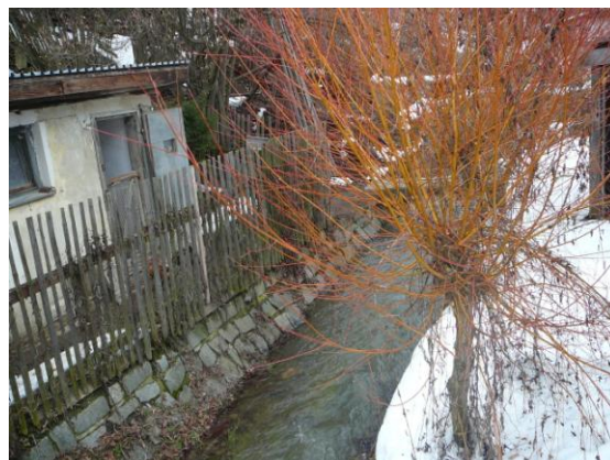
Obr. 5: Břeh zpevněný rovnáninou z lomového kamene. (4.)
