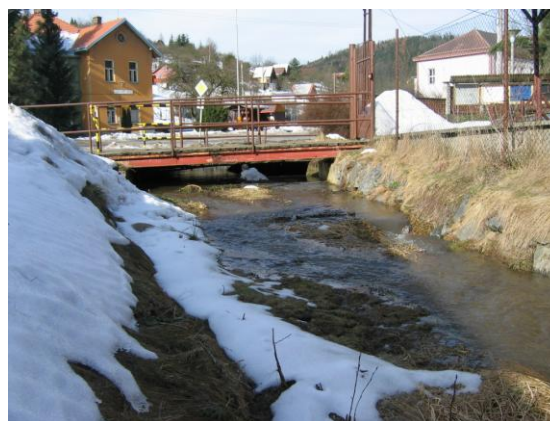
Obr. 15: Mosty s nedostatečnou kapacitou u bývalé textilní továrny. (6.)
