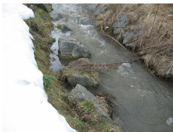
Obr. 11: Sesypané opevnění z lomového kamene do koryta potoka. (4.)
