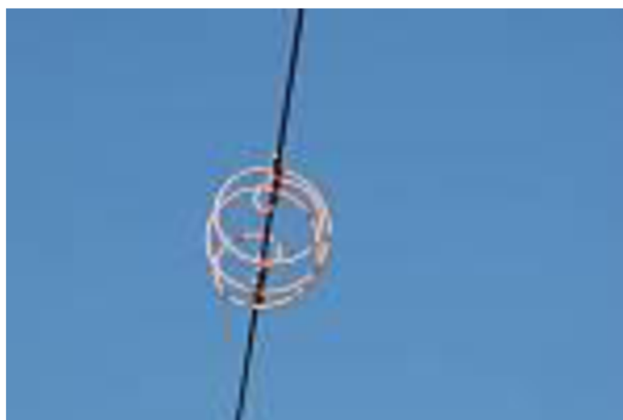
Obrázek 2 Ochranný prvek na vodiče na elektrické vedení „spirála“ (zdarsky.denik.cz)
