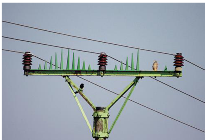
Obrázek 3 Ochrana elektrických sloupů proti dosednutí ptáků (Hlaváč a spol., 2012)
