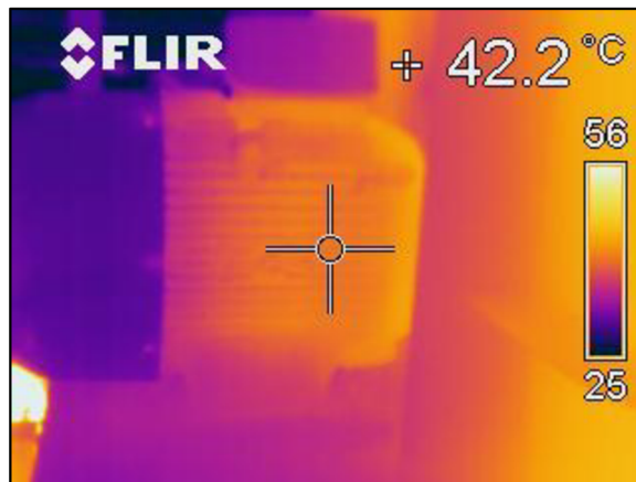
Obrázek 18: Příklad snímku s termografem.
