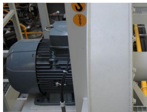
Obrázek 22: Motor pro přívod vzduchu hořákům v peci.
