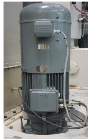
Obrázek 20: Motor pro míchání solné lázně.
