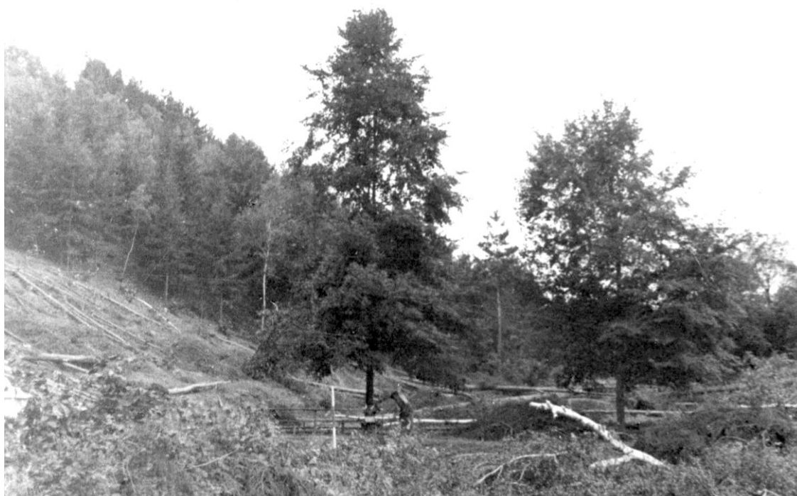
Šelše – kácení stromů, budování dálnice (Foto: paní Švihálková)
