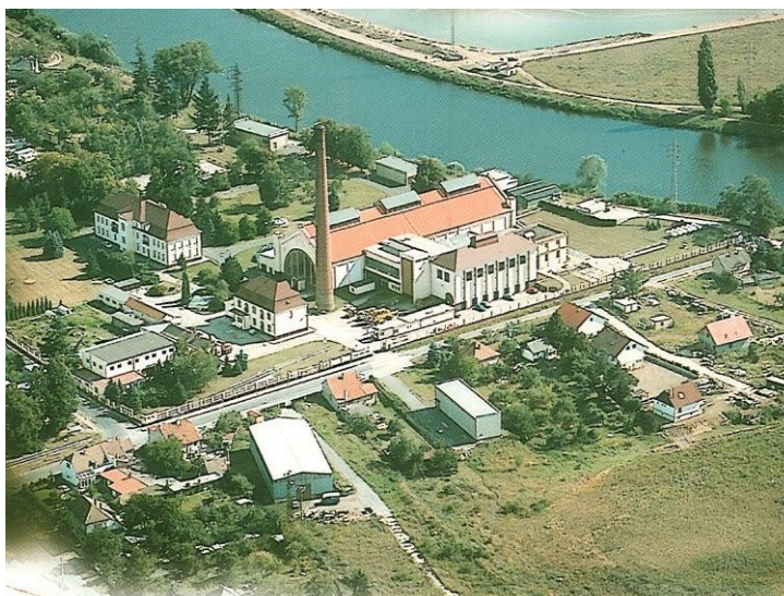
Obr. č. 4: Pohled na úpravnu vody Káraný
