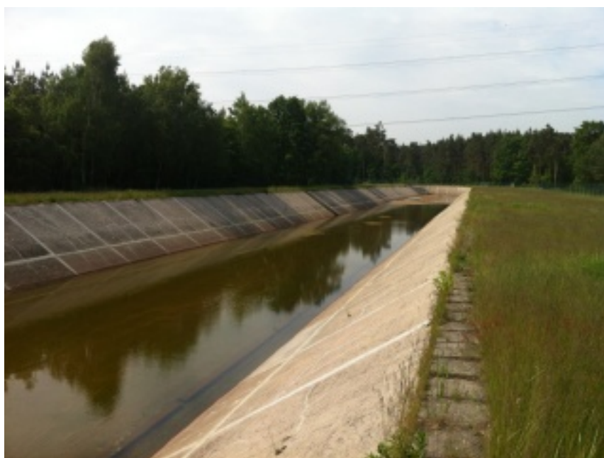
Obr. č. 3: Nádrž umělé infiltrace
