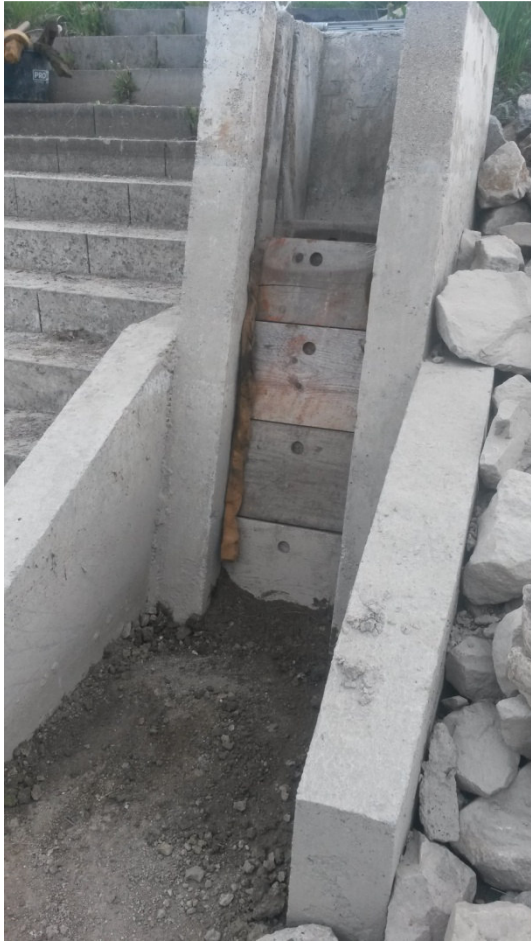
Obrázek č. 2. Vypouštěcí zařízení zabezpečené (molitany a škvára) proti úniku ryb a odtoku vody z rybníka.
