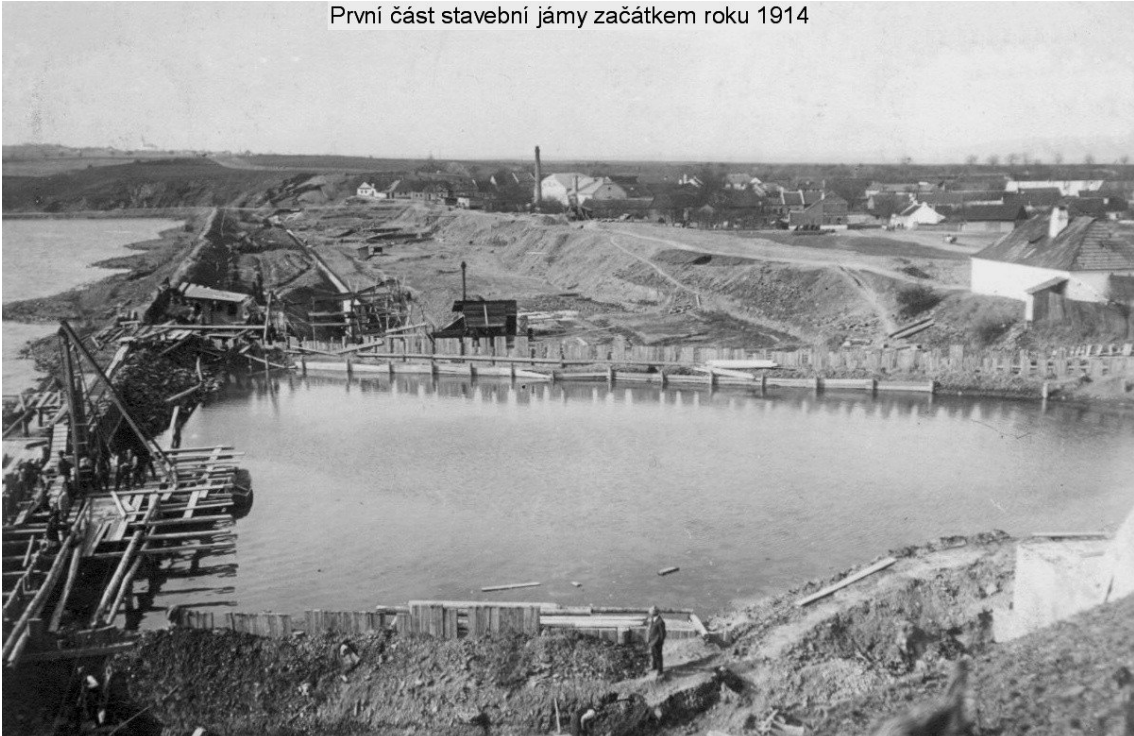
Obrázek 3. Stavební jáma Plumlovské přehrady (zdroj: Obecní úřad Mostkovice)
