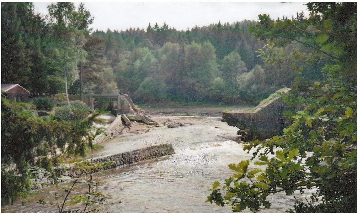
Obrázek 13. Protržená hráz VD Soběnov, během povodní v srpnu 2002 (zdroj: Regiony.rozhlas.cz, 2017)
