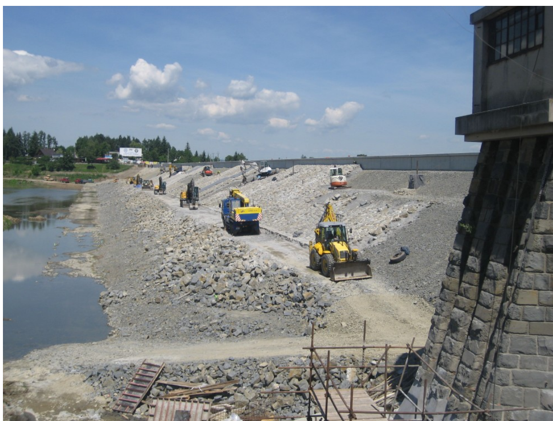
Obrázek 12. Hráz Vodního díla Plumlov během oprav. (Povodí Moravy s.p., 2019).
