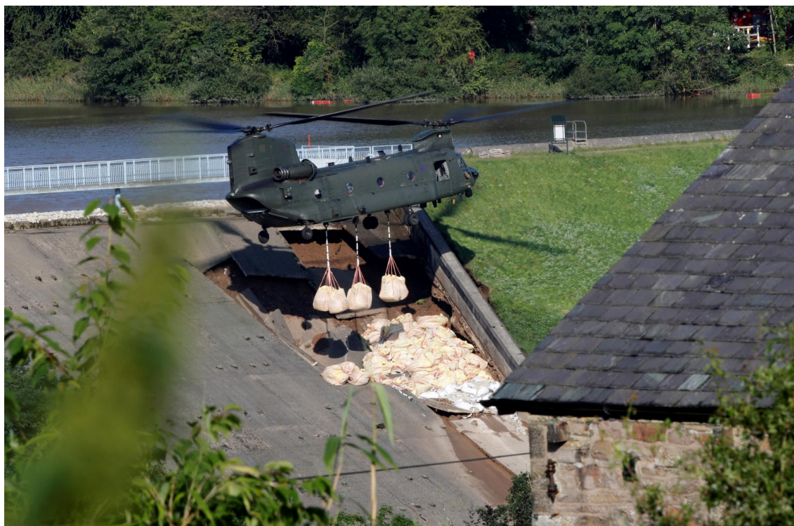
Obrázek 15. Zasypávání hráze Toddbrook reservoir (foto: Phil Noble, zdroj: Reuters)
