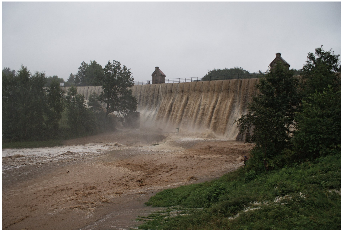
Obrázek 14. Hráz VD Mlýnice během přetečení koruny hráze (foto: Jiří Forst)
