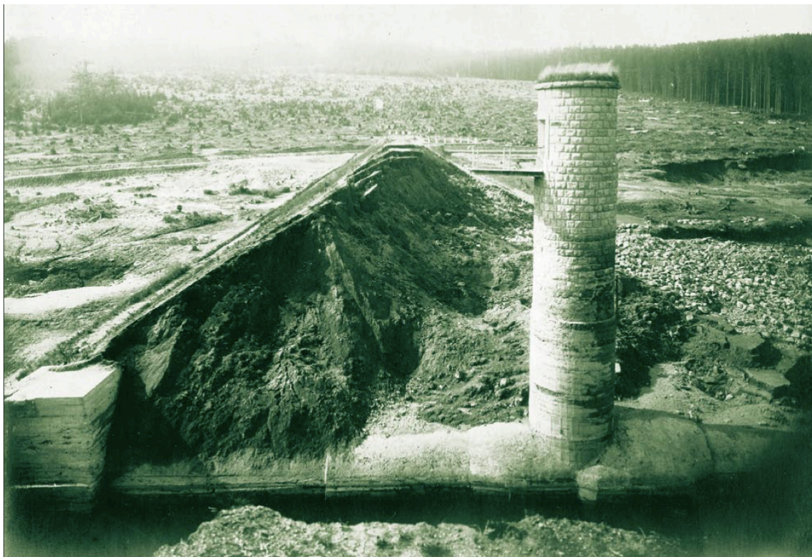
Obrázek 5. Protržená hráz přehrady Desná (zdroj: Státní okresní archiv Jablonec nad Nisou)
