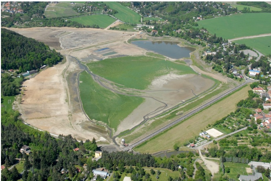
Obrázek 11. Vypuštěná přehrada během odstraňování sedimentů (Povodí Moravy s.p., 2019)
