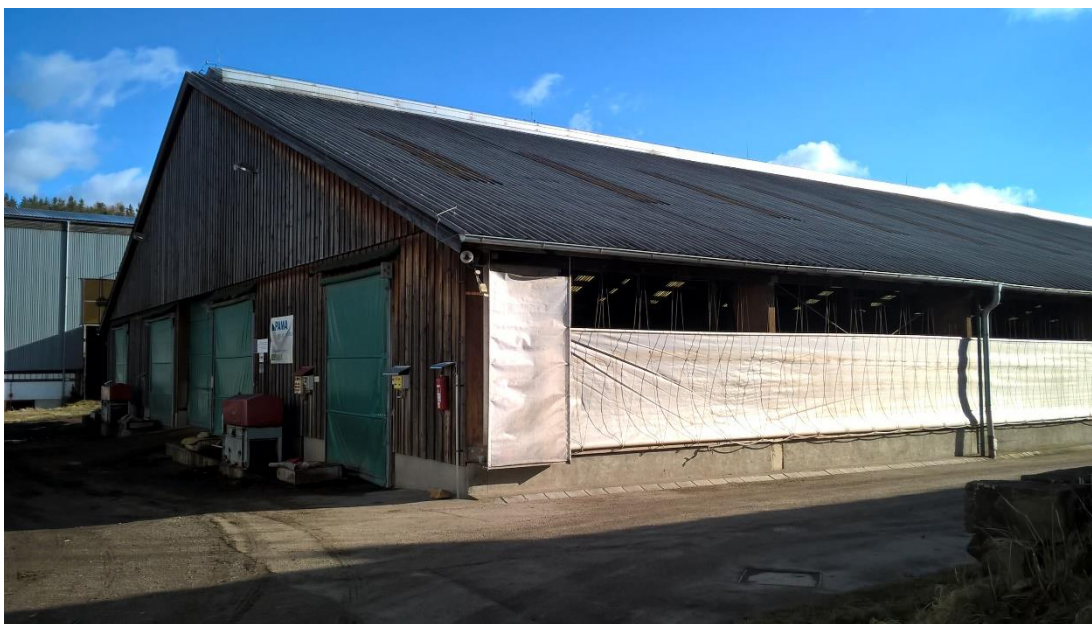
Příloha č. 1: Stáj VKK Brloh – lehká vzdušná stavba z roku 2000
