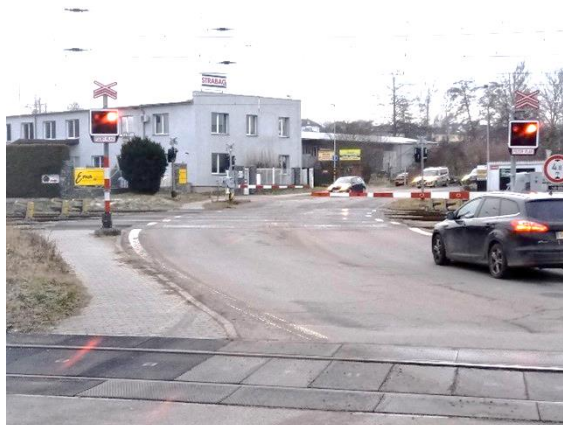
Obr. 13: Přejezd s polovičními závorami
