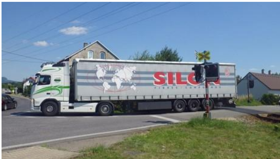
Obr. 5: Nedostatečná vzdálenost přejezdu od hranice křižovatky
