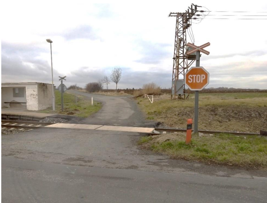
Obr. 11: Železniční přejezd zabezpečený výstražným křížem
