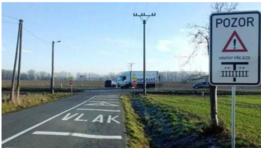
Obr. 16: Doplněná výstraha u vodorovného značení
