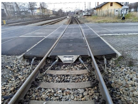
Obr. 6: Pryžová konstrukce vozovky STRAIL
