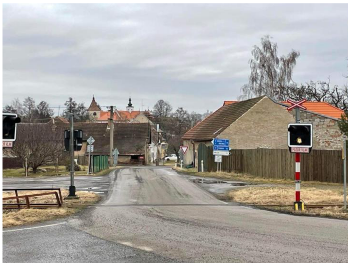
Obr. 14: Přejezd PZS bez závor
