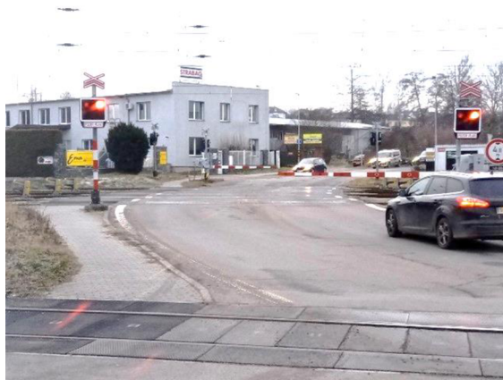
Obr. 13: Přejezd s polovičními závorami
