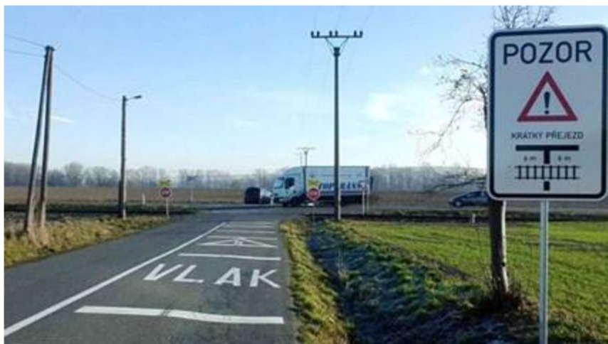
Obr. 16: Doplněná výstraha u vodorovného značení
