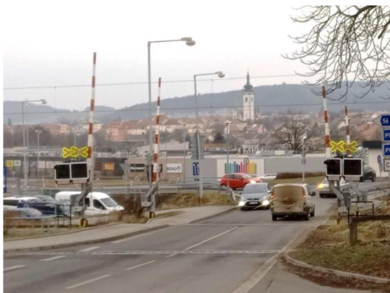
Obr. 12: Přejezd s celými závorami
