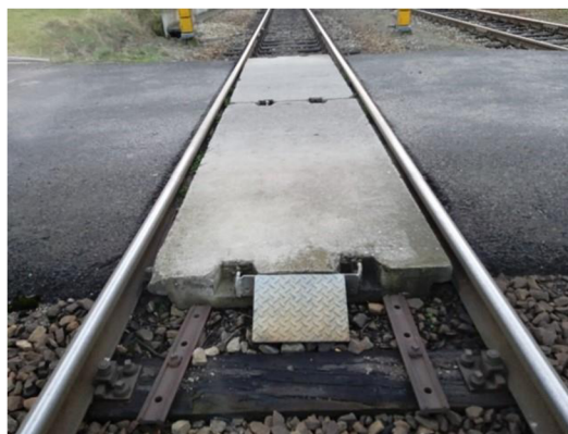
Obr. 8: Krytí železobetonovými panely
