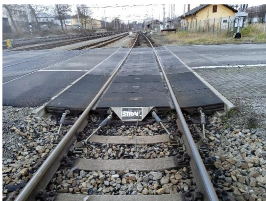
Obr. 6: Pryžová konstrukce vozovky STRAIL
