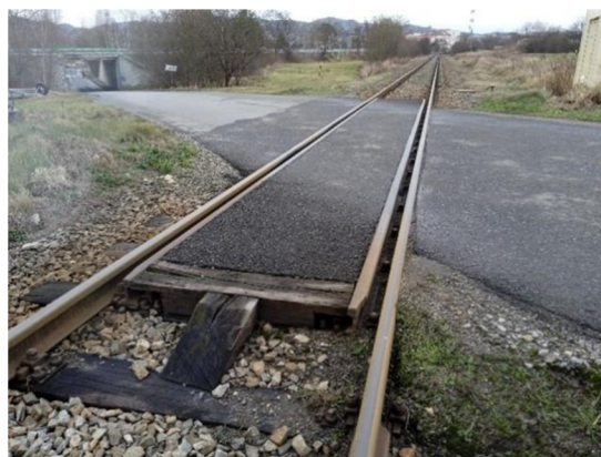
Obr. 7: Krytí totožné s povrchem komunikace
