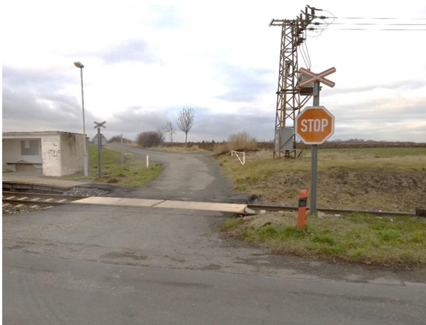
Obr. 11: Železniční přejezd zabezpečený výstražným křížem
