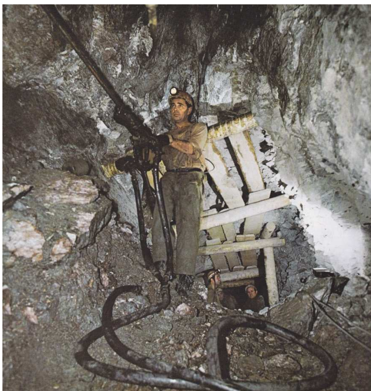
Obr. č. 51: Vrtací práce (převzato: Gutwirth, Kolek, 1985).
