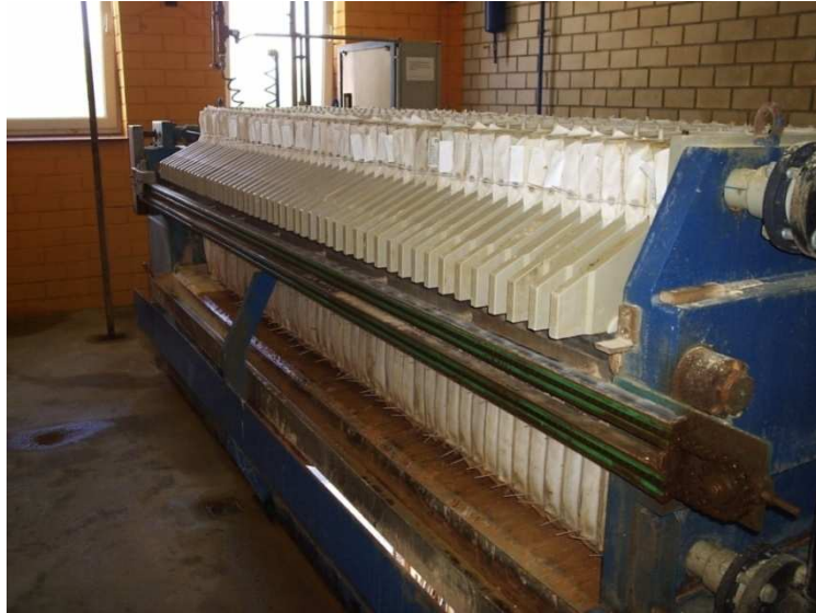
Obr. č. 3. Kalolis- zpracování kalu odstraněného železa (Foto: autorka, 2010).
