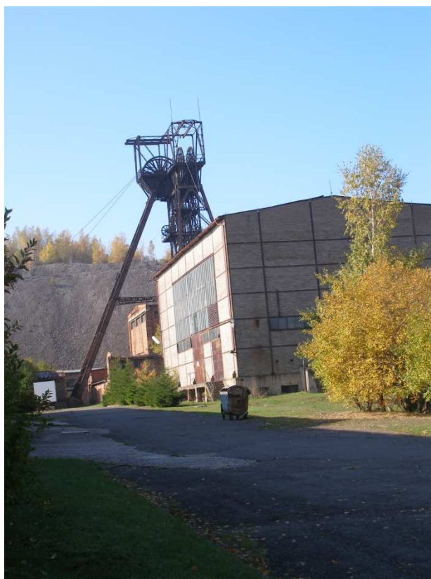
Obr. č. 57: Areál šachty č. 15, 2010 (Foto: autorka, 2010).
