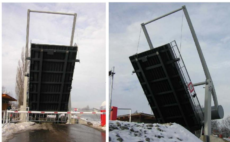
Obr.4) Pohledy na sklopený most
