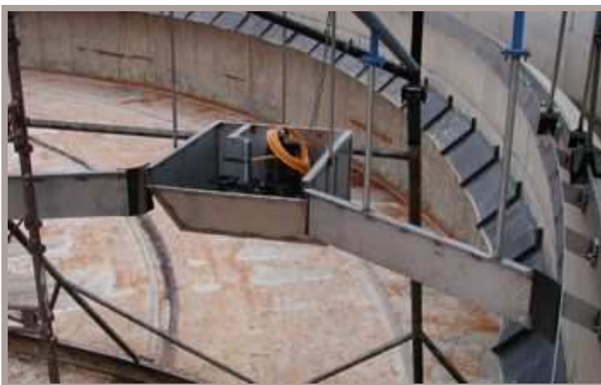
Obr. 8 Pohyblivá jímka s čerpadlem [7]
