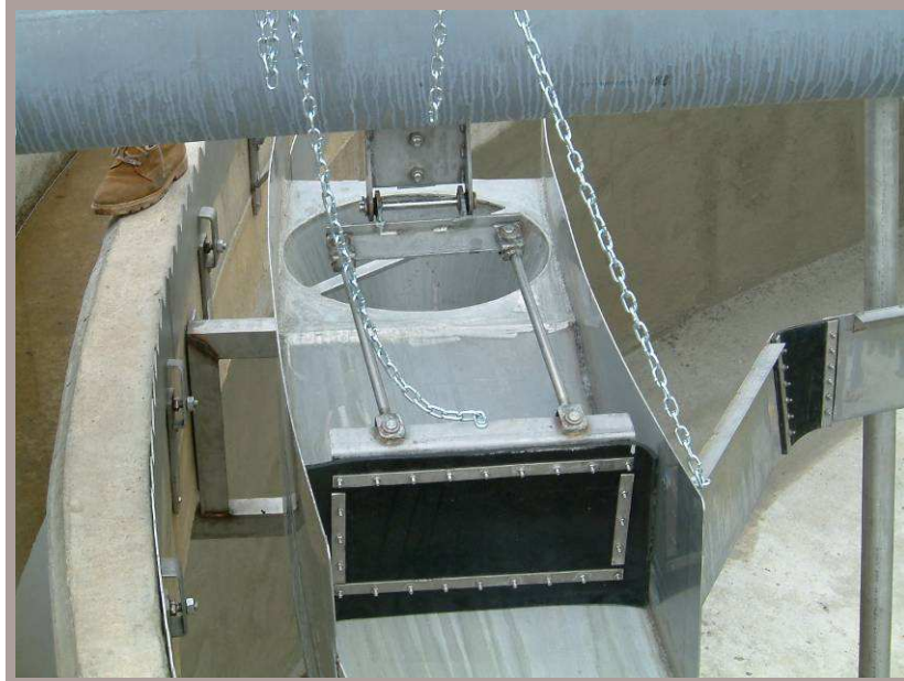
Obr. 5 Jímka pevně uchycená k okraji nádrže [5]
