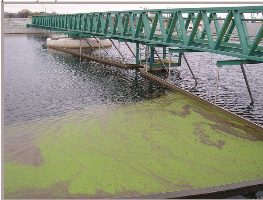
Obr. 7 Jímka pohybující se společně se stíráním hladiny [8]
