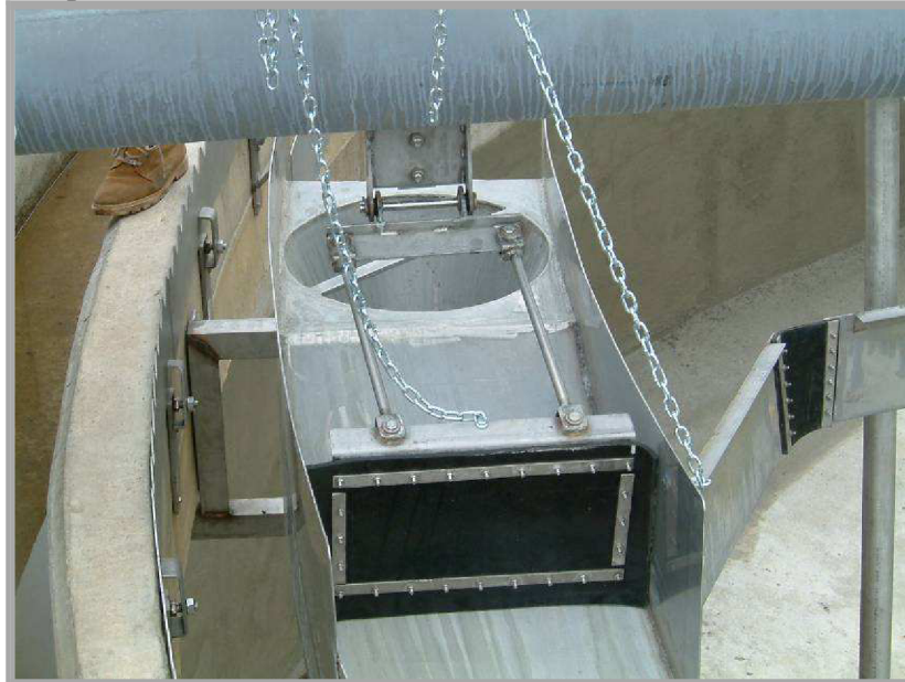
Obr. 5 Jímka pevně uchycená k okraji nádrže [5]
