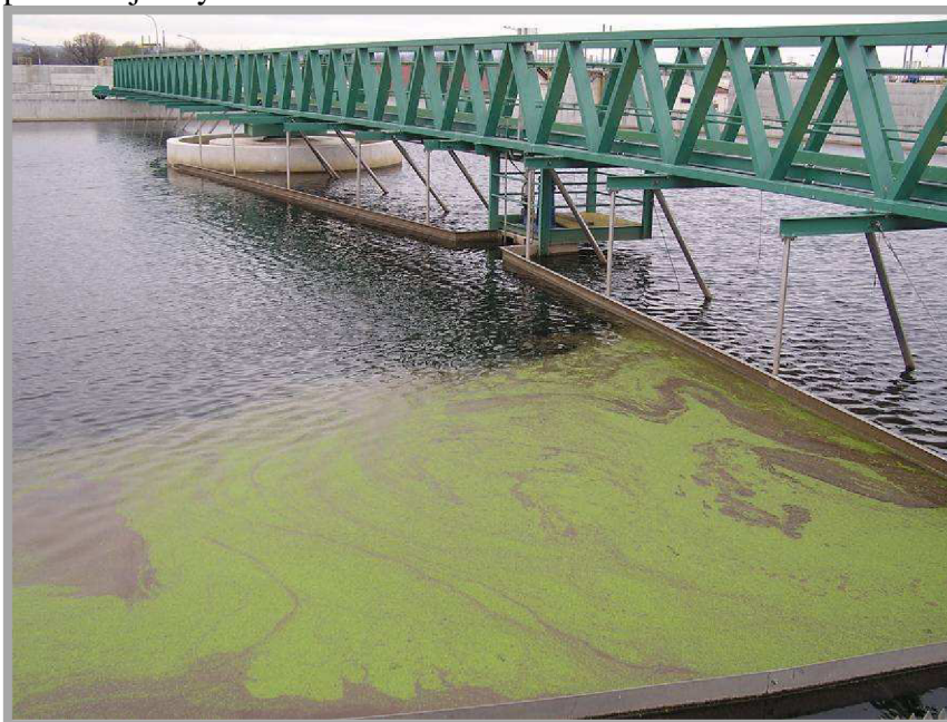
Obr. 7 Jímka pohybující se společně se stíráním hladiny [8]
