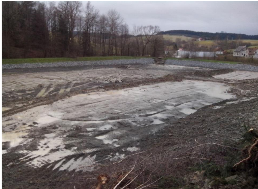
Obrázek 11: Jižní část nádrže před technologickou přestávkou, vlastní zpracování
