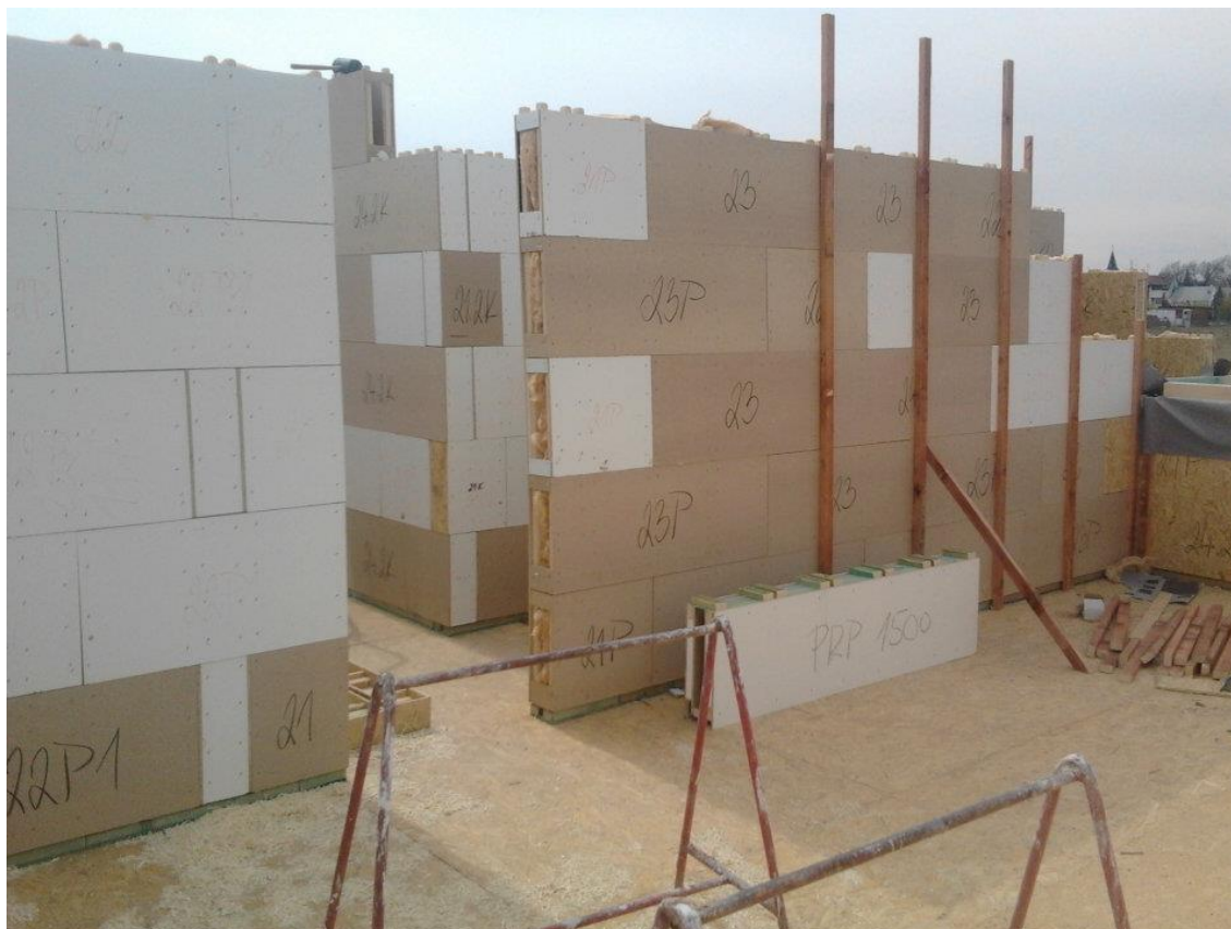
Obr. 21 Průběh stavby pomocí systému Modul-LEG
