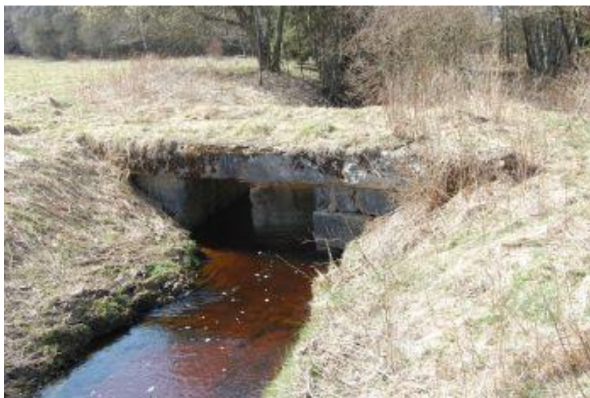
Obr. 10 Dlouhá stoka – jeden z mnoha původních žulových mostů
