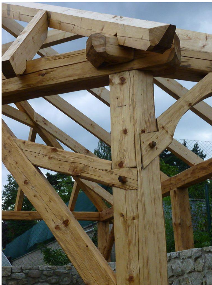
Obr. 23 Konstrukce postavená pomocí tradičních postupů
