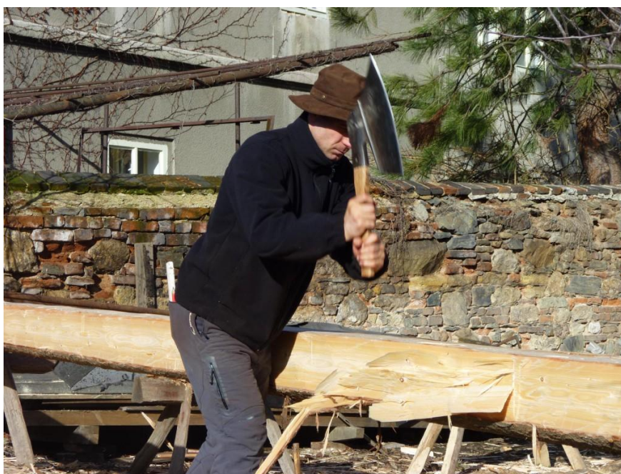
Obr. 22 Otesávání trámu tesařskou sekerou – širočinou
