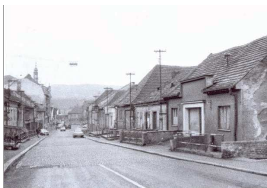
Obr. 35. Ulice Česká, po roce 1970.
