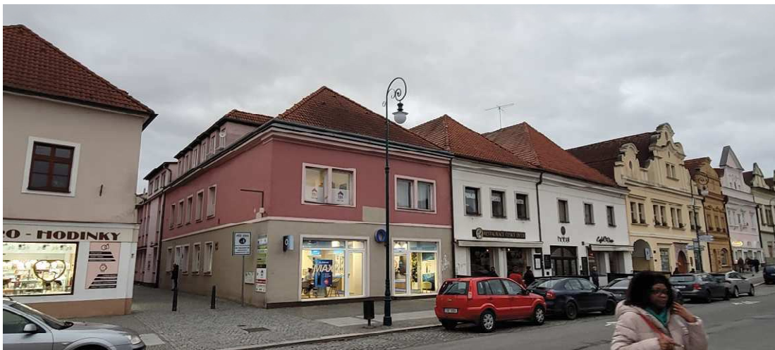
Obr. 146. Nárožní dům č.p. 85 (Pivovarská – Husovo náměstí) na pohledově exponovaném místě, znehodnocený novodobými zásahy (plastová nečleněná okna a výlohy, četné valbové vikýře do ulice, menší parabolická TV anténa na vikýři nad průčelím do ul. Pivovarská). Foto vlastní
