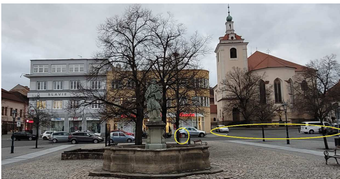
Obr. 114. Nebezpečný úsek pro chodce za kostelem sv. Jakuba, kde je plánováno zvětšení prostoru pro chodce – rozšíření chodníku. Zdroj: Foto vlastní dne 6.2.2024
