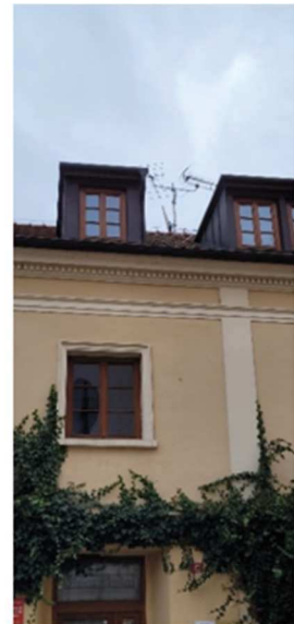
Obr.129. TV anténa na hodnotném objektu, Seydlovo náměstí
