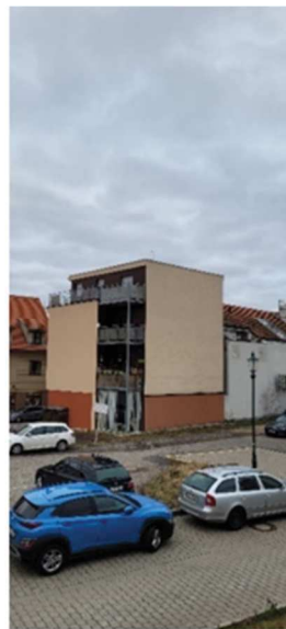
Obr.124.Obytný dům s plochou střechou a balkony, ul. Biřická
