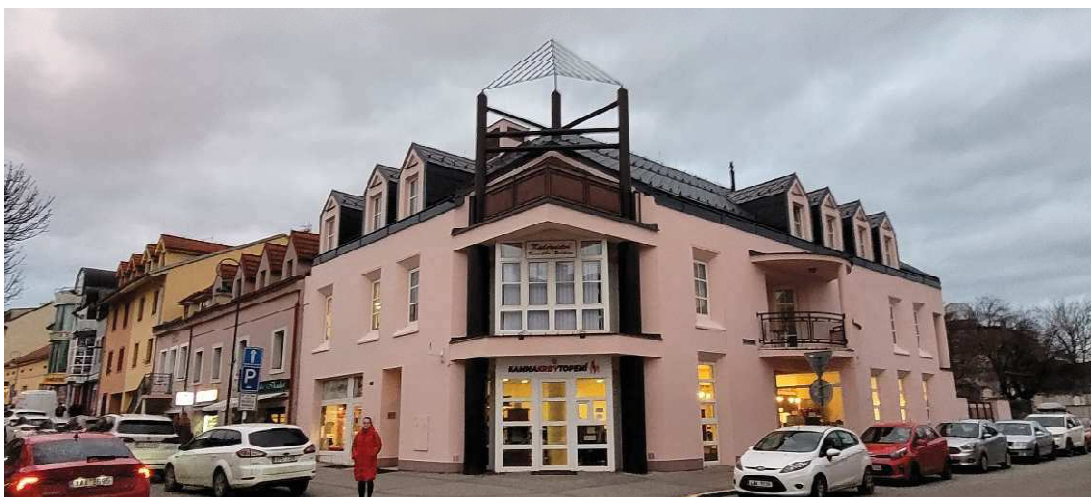
Obr. 149. Nárožní novodobý objekt se zdůrazněným moderním nárožím, plastovými okny a dveřmi a naddimenzovanými četnými vikýři na místě zaniklé řadové zástavby (roh ulic Česká a novodobé Čertovky). Foto vlastní
