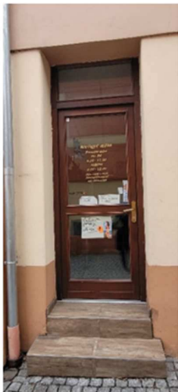
Obr.127.Doplňené schody do přízemí budovy, ul. Kostelní
