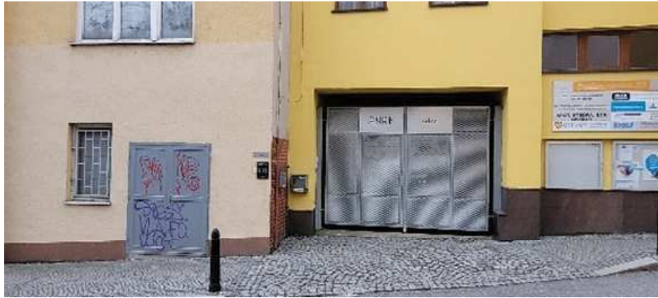
Obr. 121. Nevhodné použití kovu ve světlých barvách místo tradičního dřeva. Vrata jsou navíc v lesklém provedení. Foto vlastní.
