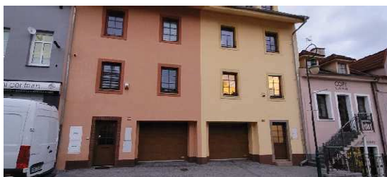
Obr. 151. Lamelová rolovací garážová vrata, ul. Česká
