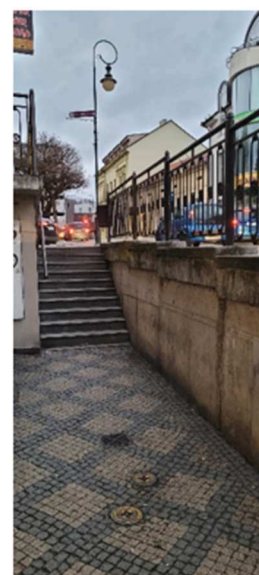
Obr.138. Vydlážděný chodník a zvýšený terén, ul. Česká
