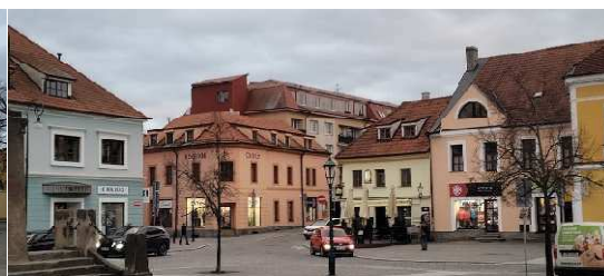
Obr.118. Narušení kompozičních vztahů vytvořením novodobé nevhodné dominanty konkurující dominantám kulturně historickým a hodnotným stavebním dominantám na náměstí. Čtyřpatrový panelový obytný dům v ul. Na Klášteře (v pozadí), pohled z náměstí.
