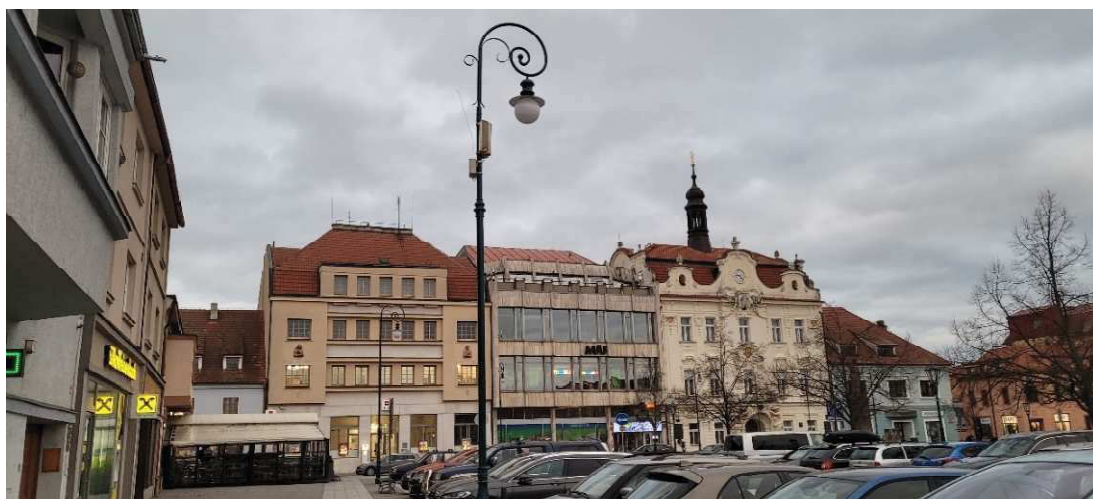
Obr. 153. Veřejné osvětlení na Husově náměstí dle historické fotodokumentaci. Zdroj: Foto vlastní z 6.2.2024
