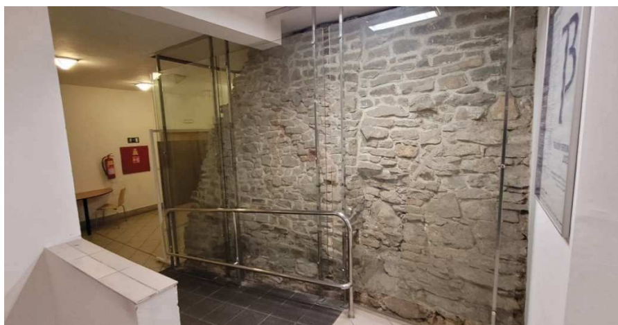
Obr. 67. Zbýtky hradebního zdiva v přízemí MÚ Beroun – vstup z ulice Na Příkopě. Zdroj: foto vlastní z 20.11.2023
