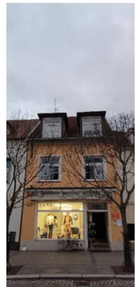
Obr.125.Naddimenzované vikýře, ul. Česká
