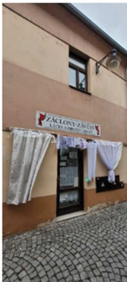
Obr.122.Narušení fasády nevhodným upoutáním, ul. Kostelní
