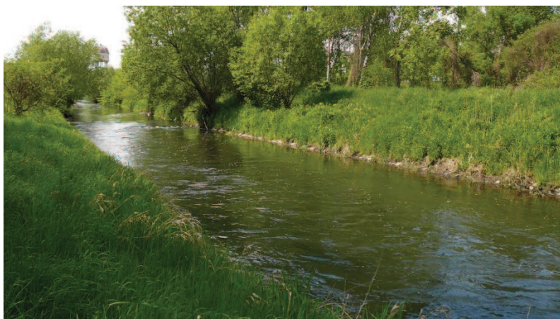
ř. km 32,0 – nad betonovým mostem, pohled proti vodě
