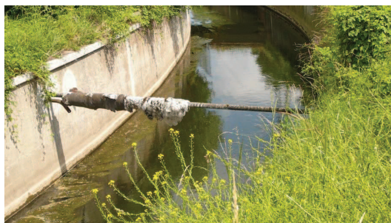
ř. km 32,8 – produktovod mezi nevyužívanými mosty, pohled po vodě
