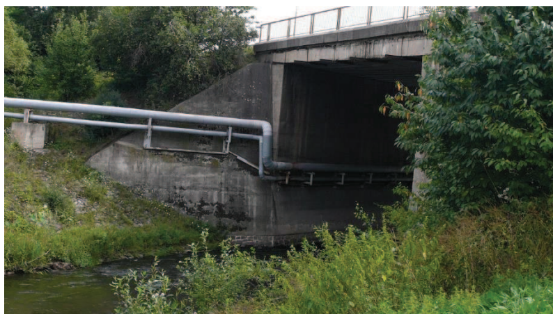
ř. km 33,0643 – most silniční I/13 (Bílina – Teplice) – pohled po vodě Zdroj: Autor DP
