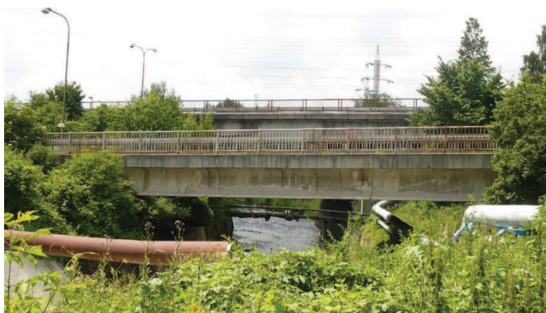
ř. km 33,017 – most silniční (Chudeřice – Chotějovice) – pohled proti vodě Zdroj: Autor DP
