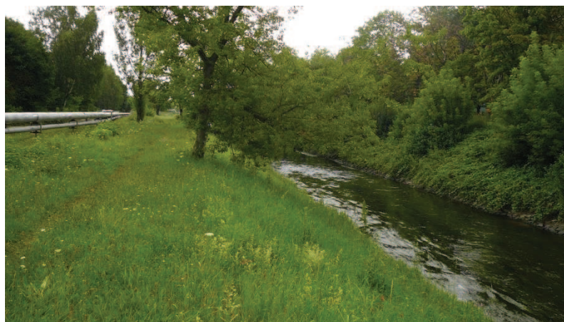
ř. km 34,6 – pohled po vodě Zdroj: Autor DP
