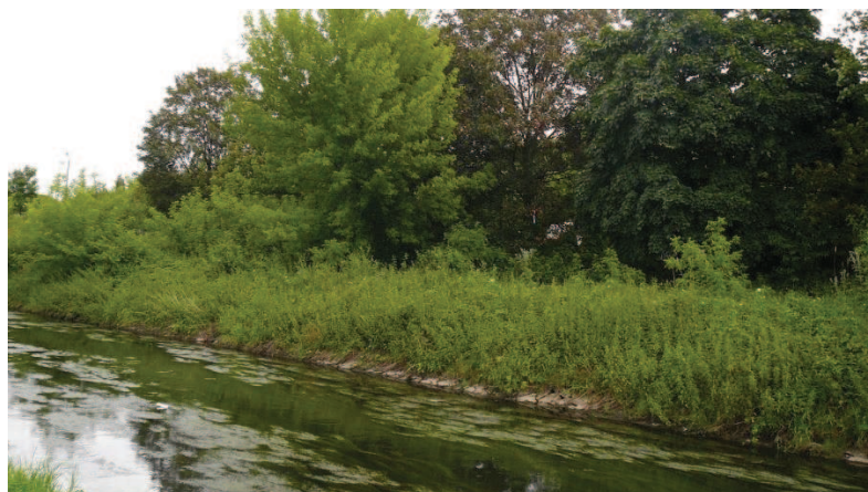
ř. km 34,0 – pohled po vodě, vpravo patrné opevnění kamennou dlažbou Zdroj: Autor DP
