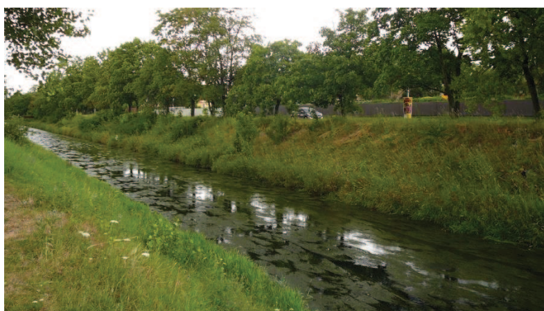
ř. km 34,8 – pohled po vodě, pravý břeh – komunikace I/13, areál Hostav
