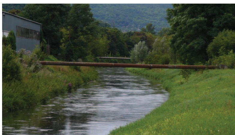
ř. km 33,8280 – produktovod nad mostem u čov, vlevo stavebniny Černý – pohled proti vodě Zdroj: Autor DP
