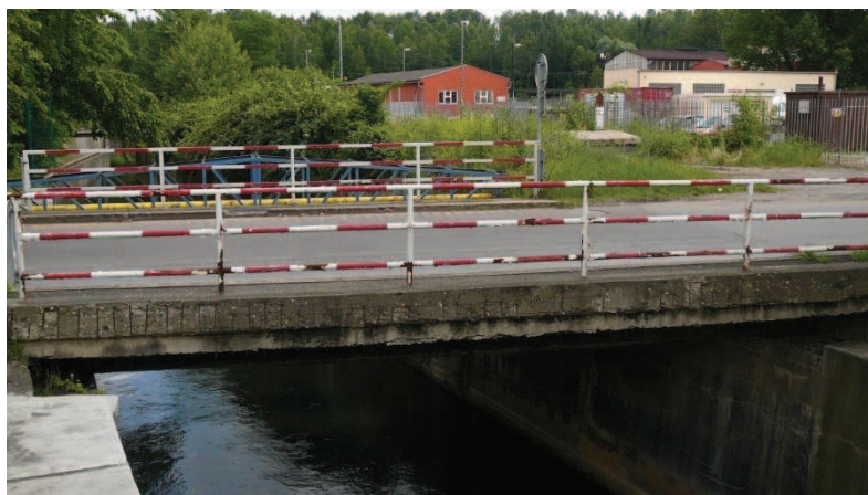
ř. km 32,9660 – detail silničního mostu ke sklárně AGC a.s. (vpravo v pozadí areál žárové zinkovny) – pohled po vodě
