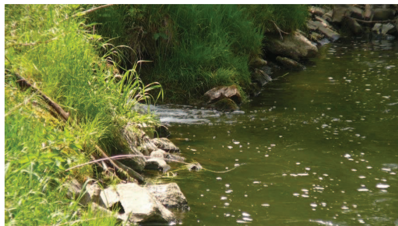
ř. km 31,8 – zaústění Štrbického potoka, pohled proti vodě Zdroj: Autor DP
