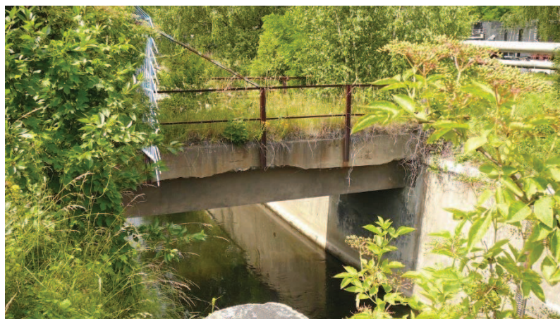
ř. km 32,8252 – nevyužívaný most u areálu sklárny AGC, pohled proti vodě Zdroj: Autor DP
