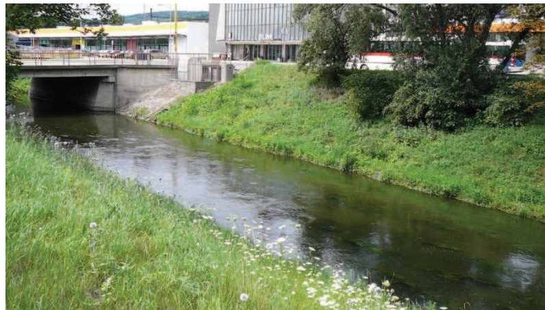
ř. km 35,1496 – profil LG Bílina ČD, konec řešeného úseku (v pozadí silniční most, vpravo nádraží ČD) – pohled proti vodě Zdroj: Autor DP
