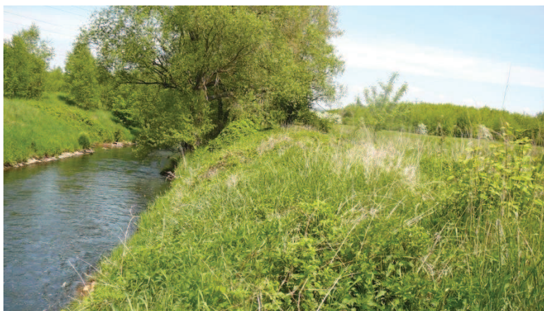
ř. km 31,7 – pod betonovým mostem, pohled po vodě Zdroj: Autor DP
