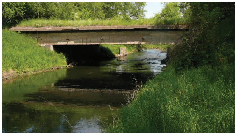
ř. km 31,8 – betonový most, pohled po vodě Zdroj: Autor DP
