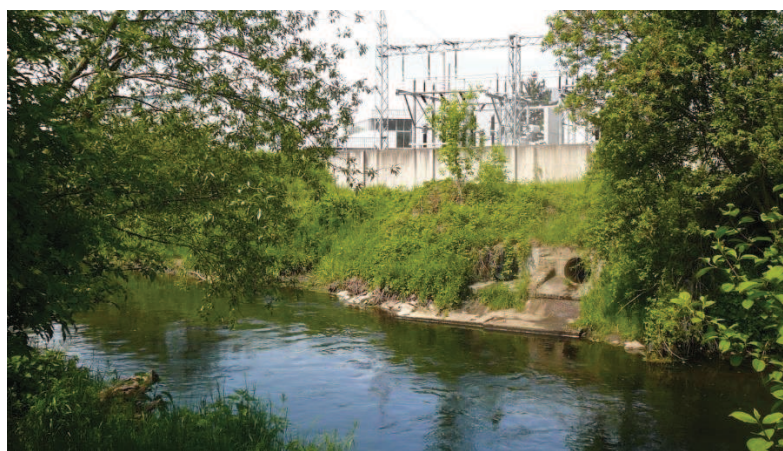
ř. km 32,077 – konec úseku – povodní konec areálu sklárny AGC - pohled proti vodě
