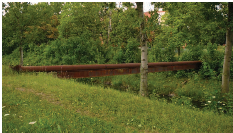
ř. km 74,7636 – produktovod, nad stupněm ve dně – pohled po vodě
