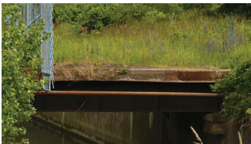
ř. km 32,7638 – nevyužívaný most u areálu sklárny AGC
