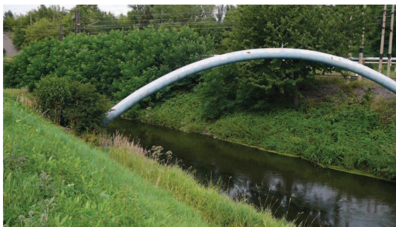
ř. km 33,1197 – klenutý produktovod nad silničním mostem I/13 – pohled proti vodě Zdroj: Autor DP
