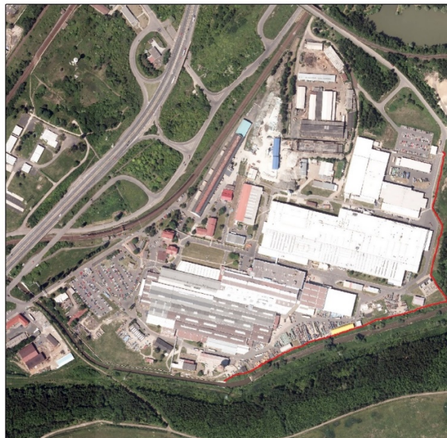
Obr. č. 36: Liniové betonové oplocení areálu sklárny AGC a.s. (červená linie). Zdroj: autor DP
