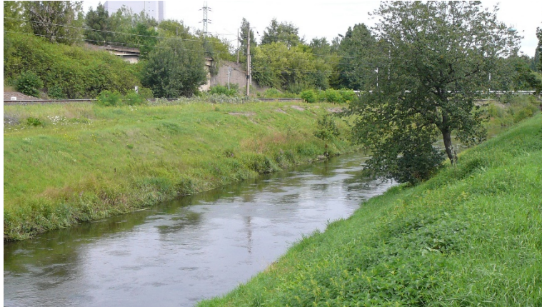
Obr. č. 42: Železniční násep a koleje pod ním na levém břehu koryta v úseku areálu ČOV - směr po proudu.
