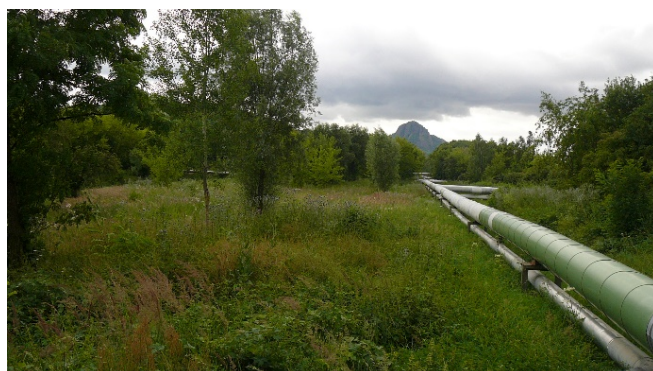
Obr. č. 38: Levobřežní inundační území řeky Bíliny (vpravo za parovodem) podél železničního náspu (vlevo mimo záběr). Zdroj: autor DP
