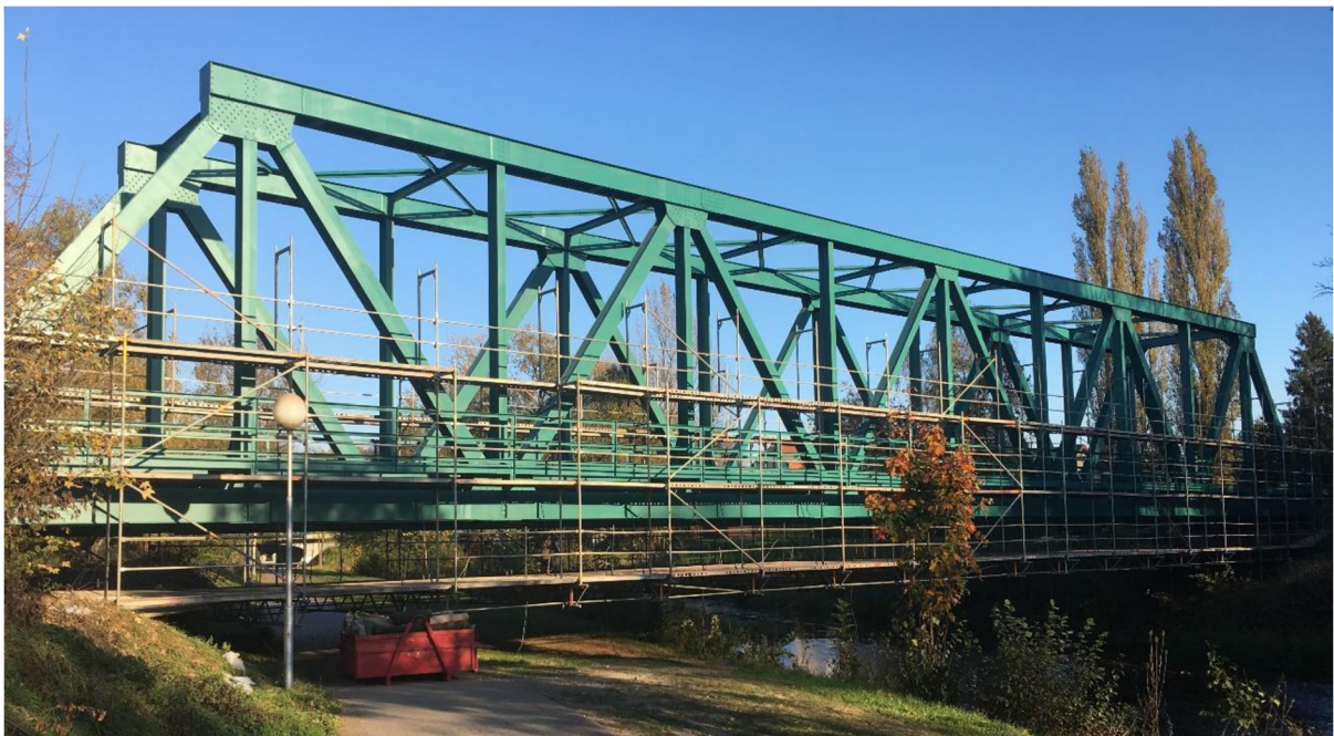
Obrázek 1.1 Železniční most přes řeku Morávku ve Starém městě u Frýdku-Místku
