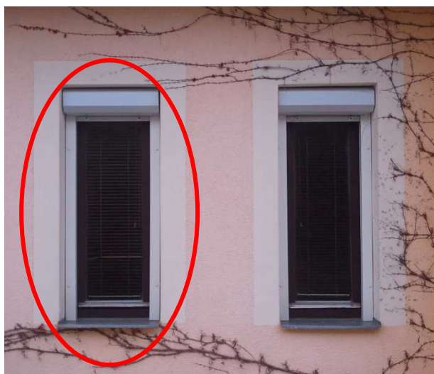
Obr.11.14: Pohled na okno č.4 z exteriéru.
