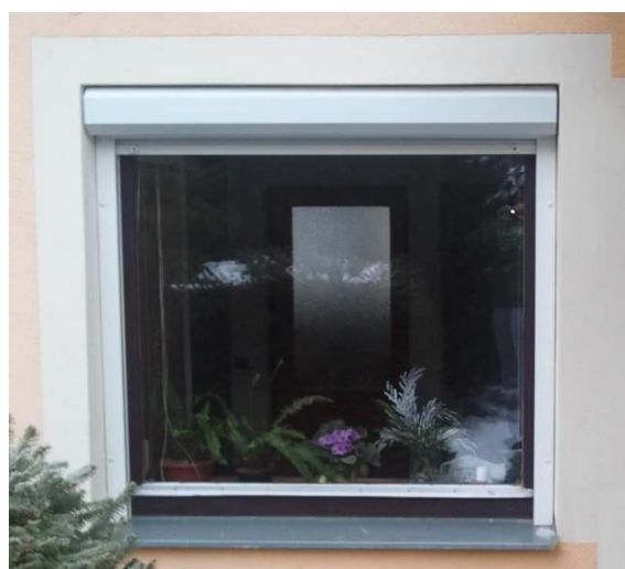
Obr.11.12: Pohled na okno č.3 z exteriéru.
