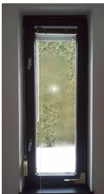
Obr.11.13: Pohled na okno č.4 z interiéru.
