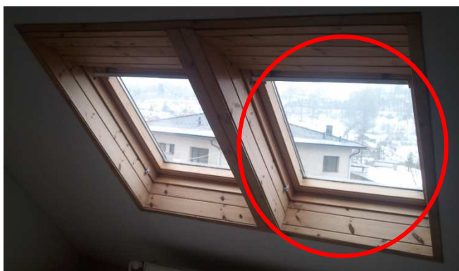
Obr.11.9: Pohled na okno č.2 z interiéru.
