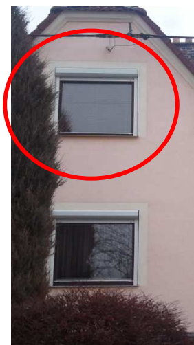
Obr.11.8: Pohled na okno č.1 z exteriéru.
