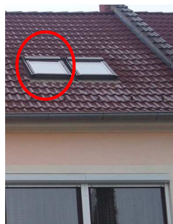
Obr.11.10: Pohled na okno č.2 z exteriéru.
