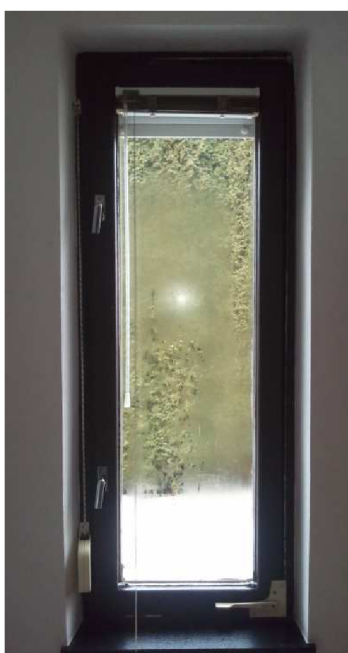
Obr.11.13: Pohled na okno č.4 z interiéru.
