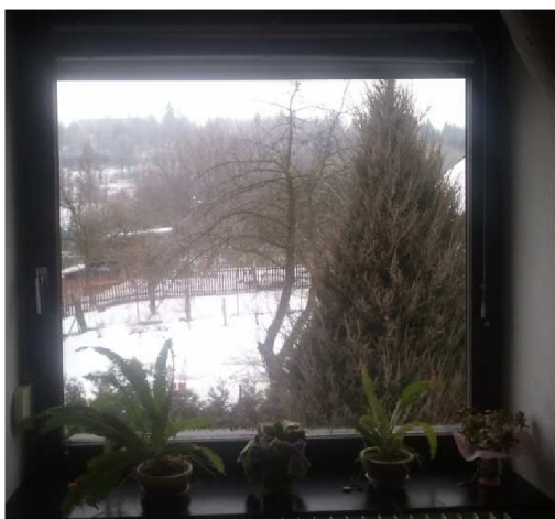
Obr.11.7: Pohled na okno č.1 z interiéru.
