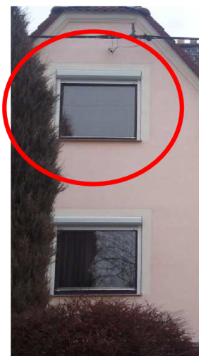
Obr.11.8: Pohled na okno č.1 z exteriéru.
