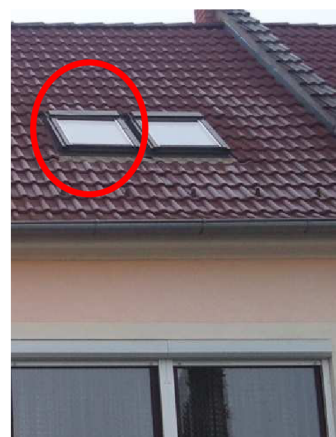
Obr.11.10: Pohled na okno č.2 z exteriéru.
