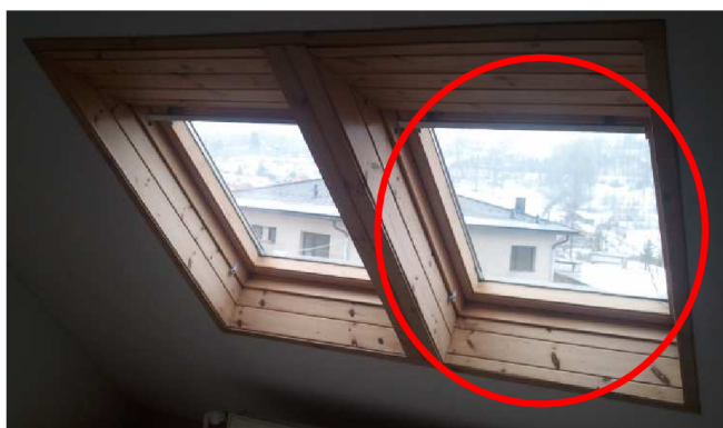
Obr.11.9: Pohled na okno č.2 z interiéru.
