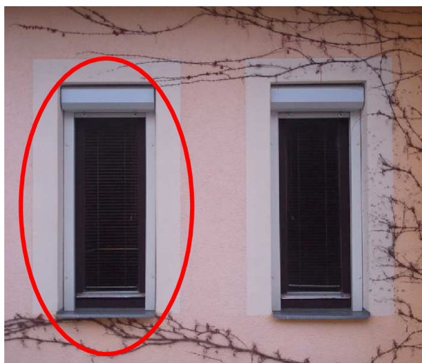
Obr.11.14: Pohled na okno č.4 z exteriéru.
