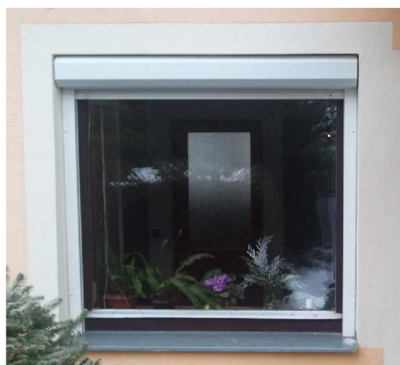
Obr.11.12: Pohled na okno č.3 z exteriéru.
