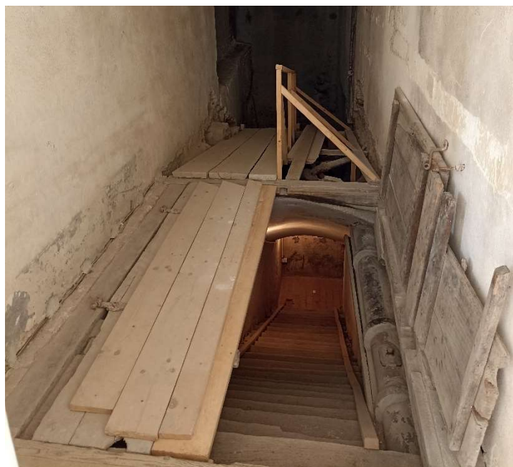
Obr. č. 39: 1NP měřené části objektu, schody dolů vedou do 2PP a dveře v podlaze slouží jako pochozí plocha do 1PP, [Autor]
