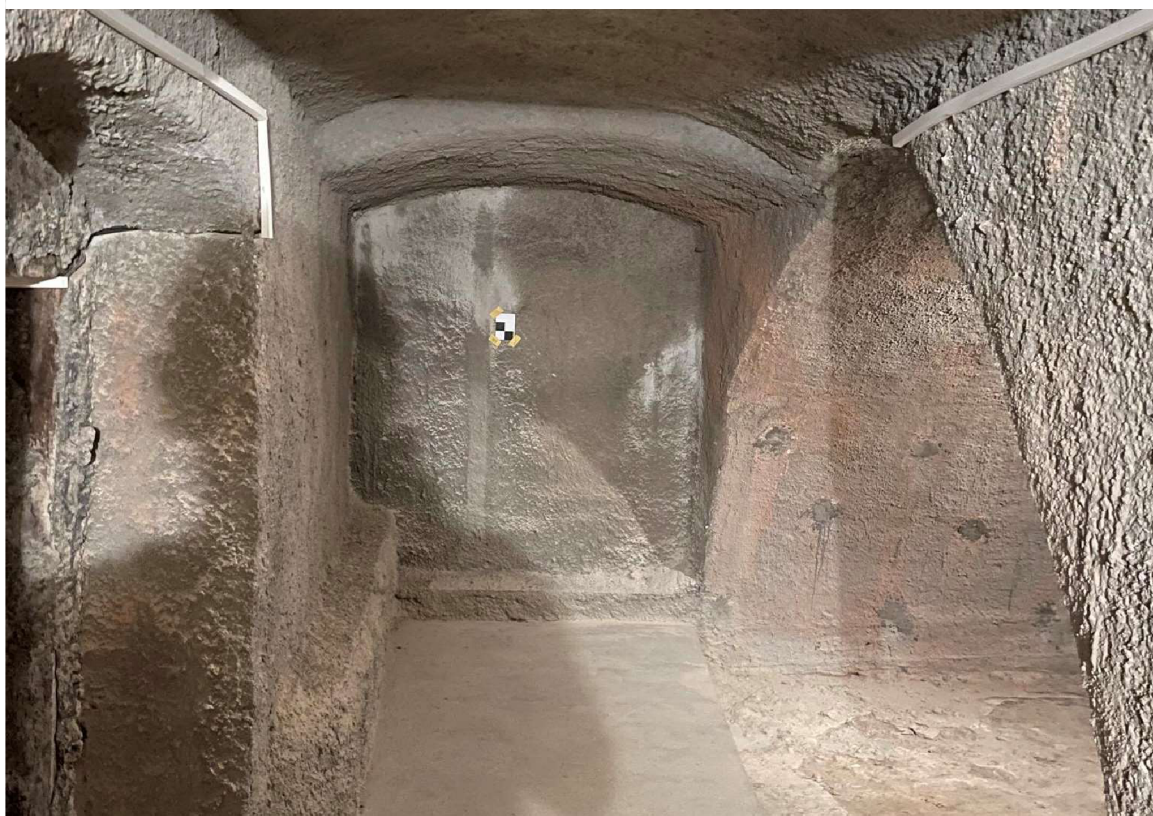
Obr. č. 6: Fotografie sklepů po sanací, totožné místo jako na minulé fotografii, [Autor]
