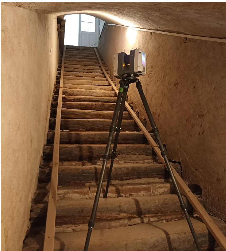
Obr. č. 15: Měření laserovým skenerem, [Autor]
