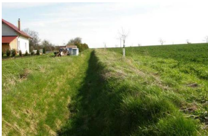
Obrázek 9: Záchytný příkop (Novotný et al., 2017)
