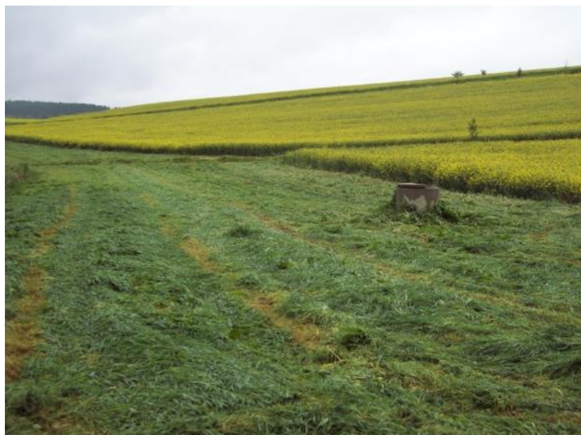
Obrázek 7: Svodný průleh – zatravněná údolnice se stabilizací dráhy soustředěného povrchového odtoku (Kadlec et al., 2014)
